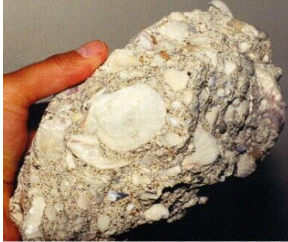
Şekil 1.6: Avcılar bölgesindeki bir yapıya ait beton parçası [12].
