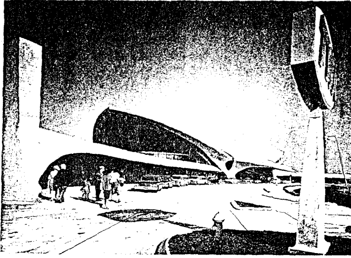
Şekil 5.13.1.1 Kanatlarını açmış bir kuş görünümündeki T.W.A. binası, New York, 1962,
