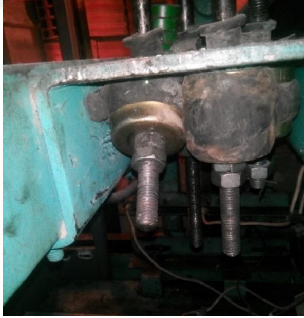
Resim 4.4 Uygun olmayan kabin askı halat bağlantısı
