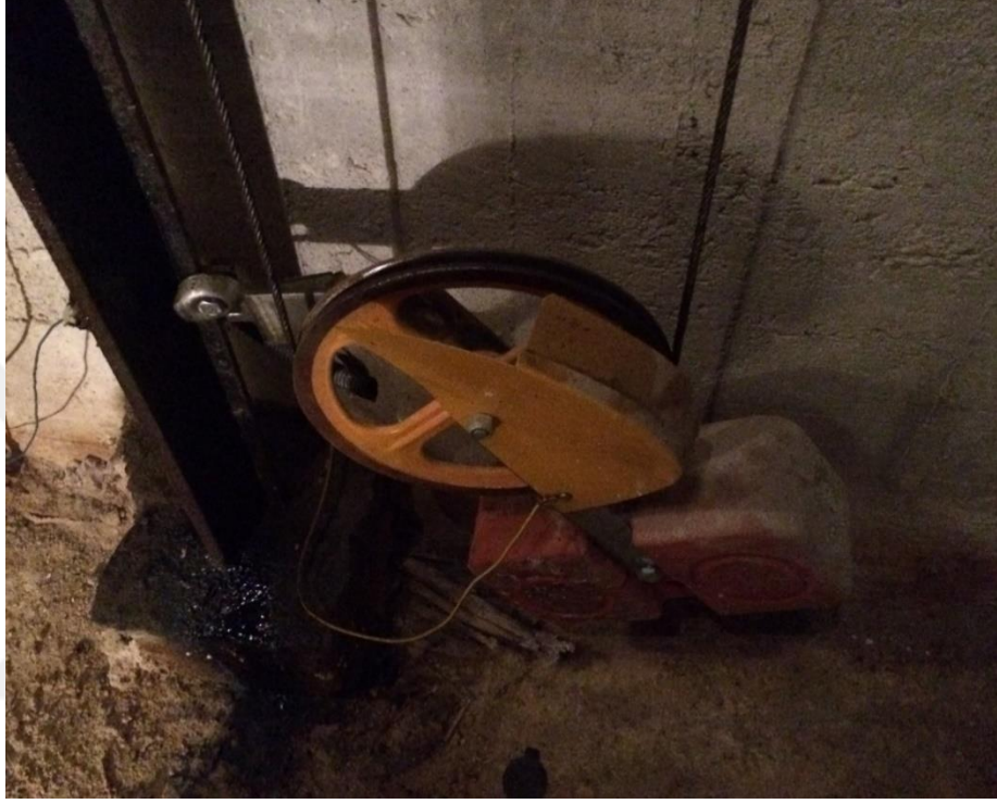
Resim 4.2 Uygun olmayan regülatör alt makarası
