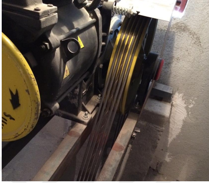
Resim 4.5 Kat işaretlemesi silinen halatlar
