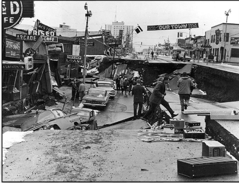
Şekil 1.2. 1964 Alaska Depremi Sonrası Zemin Sıvılaşması [3]
