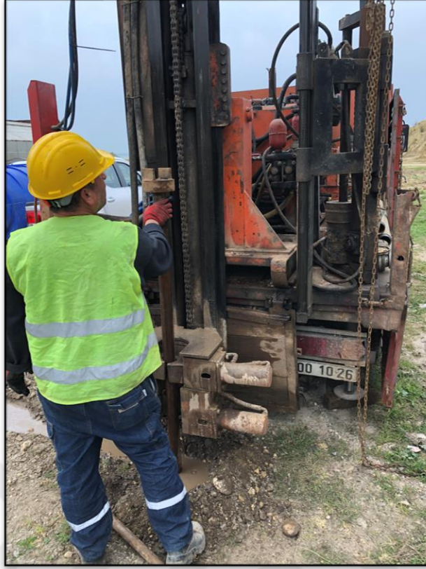
Şekil 4.6. Çalışma bölgesinde yapılan sondaj çalışmaları
