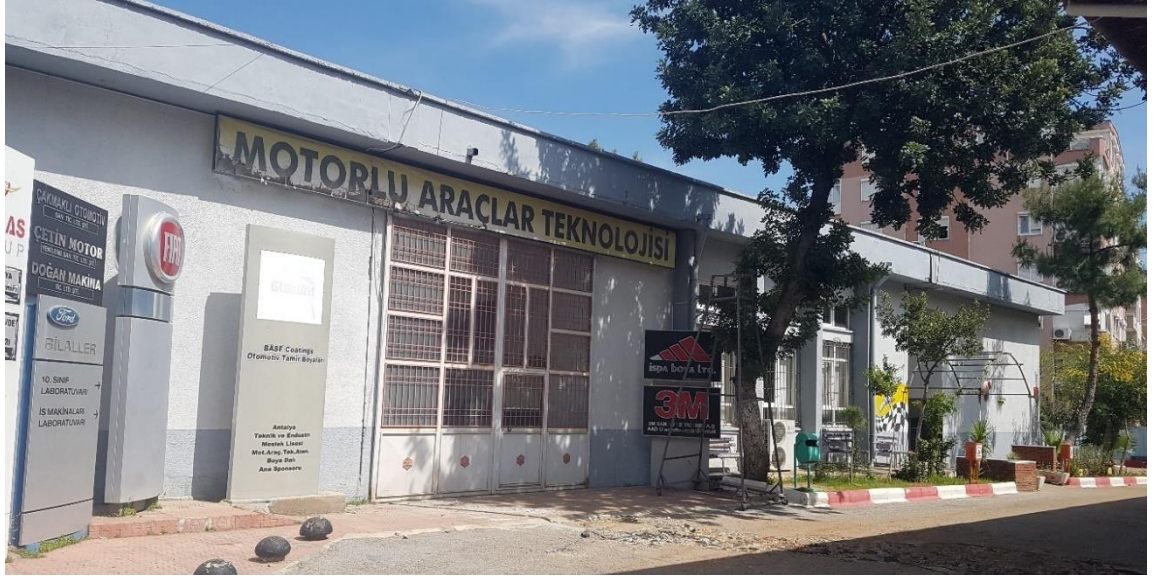
Şekil 4.22. Motor atölyesi yönünden Motor Atölyesi Bloğu
