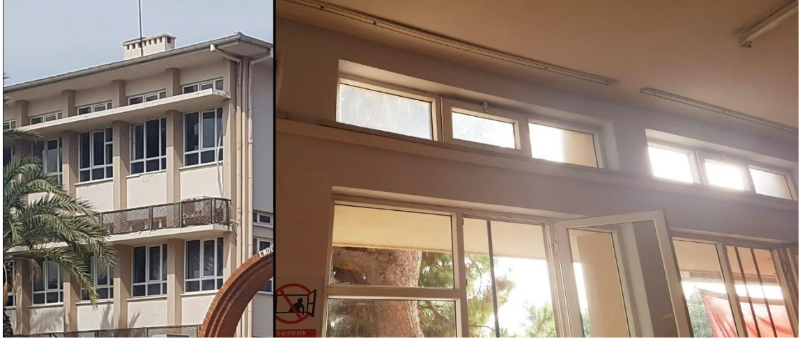
Şekil 4.28. Yapıdaki ışık rafı detaylarının binanın dışından ve içinden görünümü
