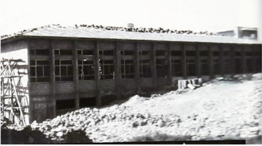
Şekil 4.3. 1969 yılına ait Elektrik Bölümü Bloğu inşaatından bir görünüm (ANTEMDER, 2020)
