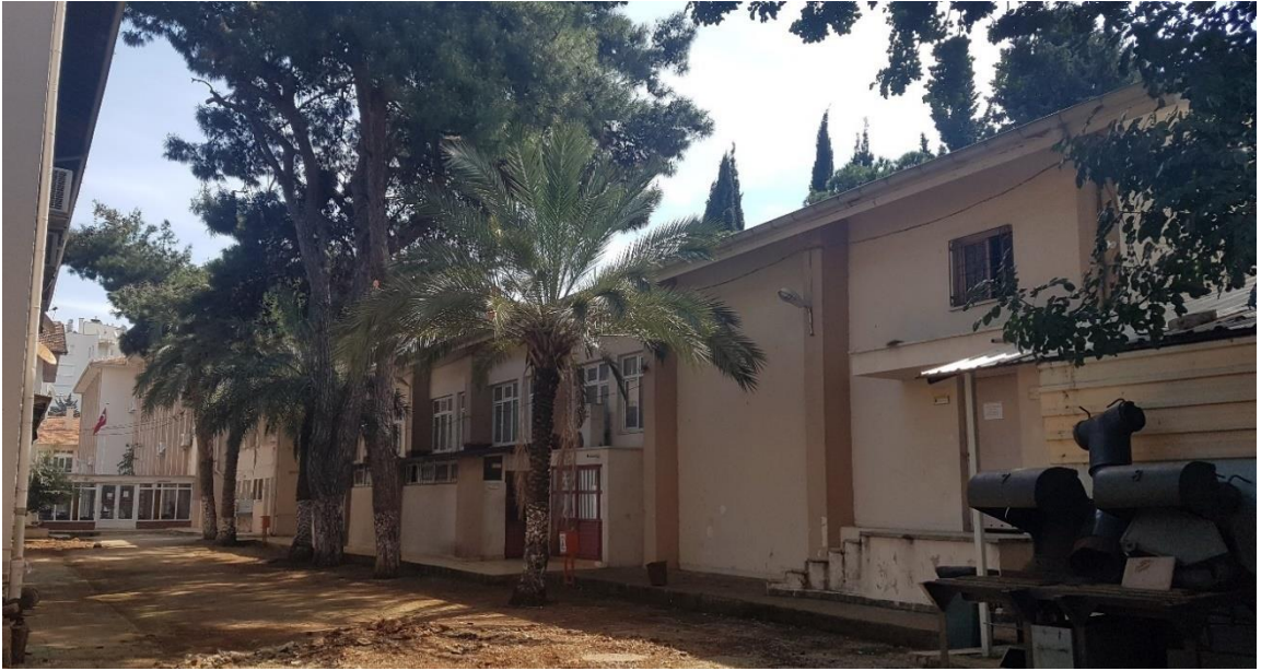
Şekil 4.18. Yan bahçe cephesinden mevcut spor salonu
