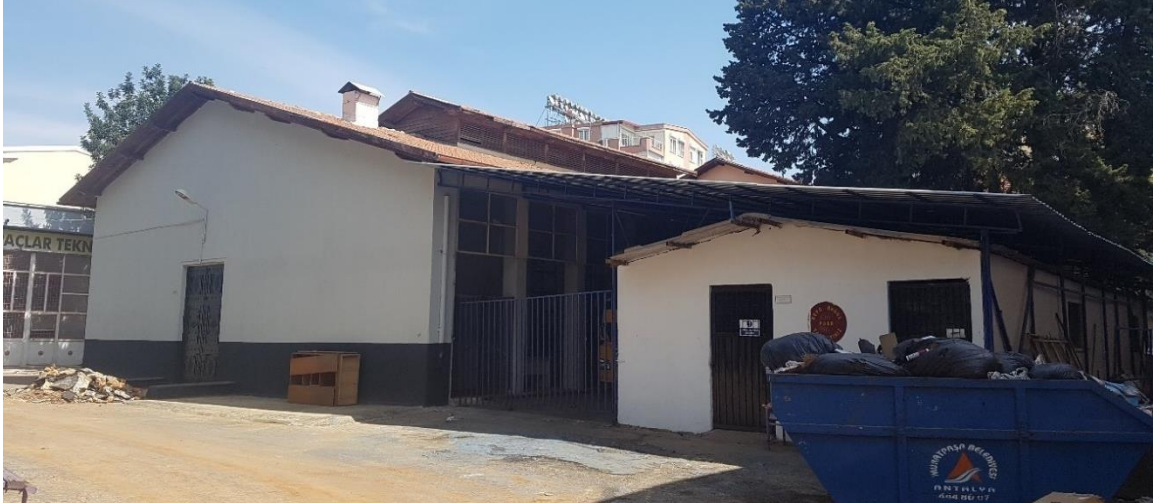
Şekil 4.10. Doğu bahçe cephesinden B Blok
