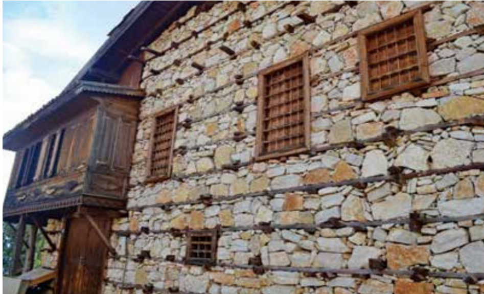
Şekil 2.22. Sarıhacılar mevki Akseki Düğmeli ev cephesi örneği görünümü (Manav, 2018)
