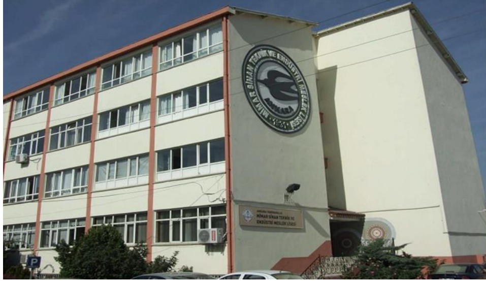
Şekil 2.14. Ankara Mimar Sinan Mesleki ve Teknik Anadolu Lisesi ön cepheden görünümü (URL-7, 2020)
