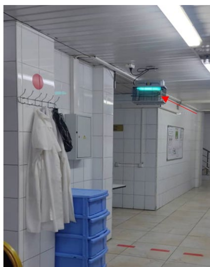
Сүрөт 4.24. Кошумча жарыктандыруунун жайгашуусу (а) жана инсектициддик жарык тузактары (б)
