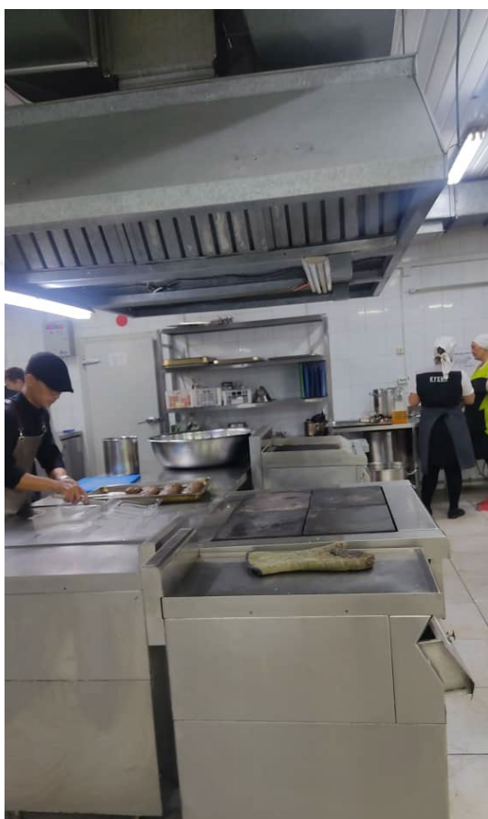
Сүрөт 4.15. Биринчи ысык цех. Арал түрүндө жайгашкан секциялуу модулданган жылууулук жабдыктар
