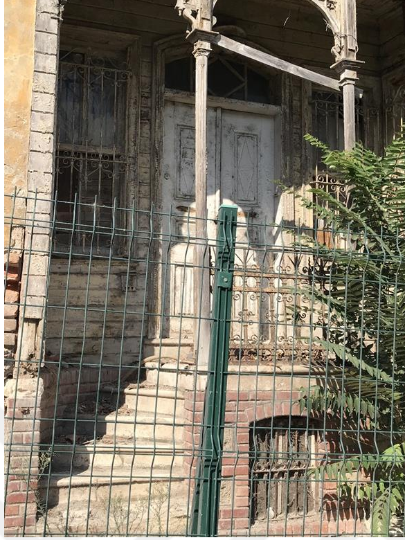
Şekil 28 Konut Yapısı (ön cephe giriş kapısı) (İstanbul Büyükçekmece 329 ada 6 parsel) (Süleyman, 2020)
