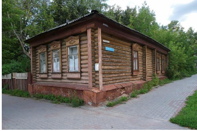
Şekil 2 Ahşap Yığma (Çantı) Yapı Örneği ( https://tr.wikipedia.org/wiki/%C3%87ant%C4%B1#/media/Dosya:Noginsk_Rabochaya_89_02.JPG (Erişim Tarihi 26.06.2021)).
