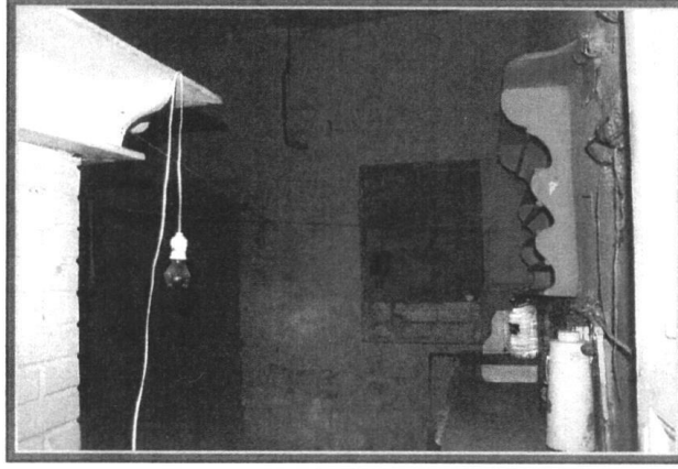
Resim 14: Mevcut Mutfakın Kuzey Duvarındaki Kapatılan Pencere Boşlukları
