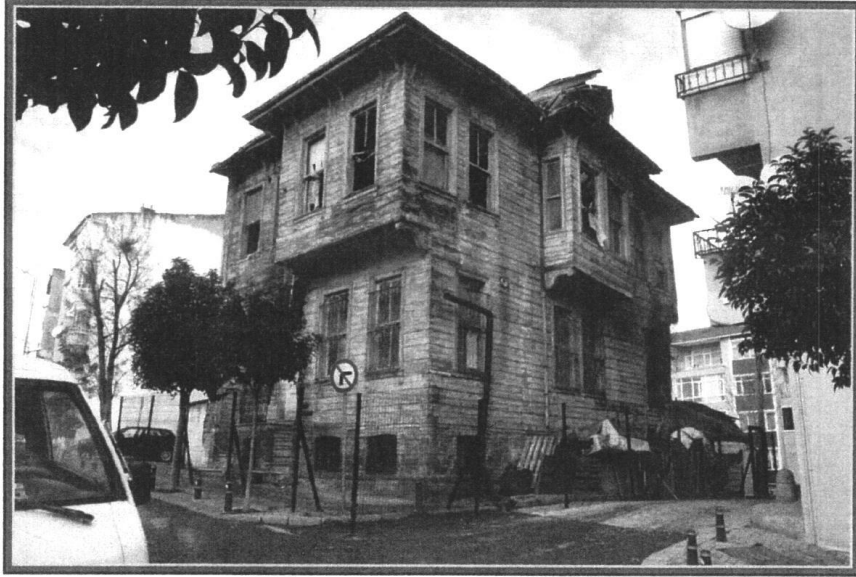
RESİM 1 : Tarihî yapı genel görünümü
