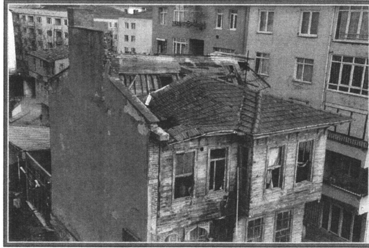
RESİM 22: Yapı çatısı üst görünümü
