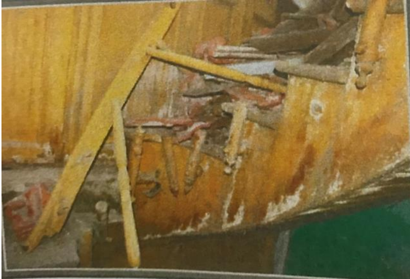
Şekil 29 Merdivenler (İstanbul Büyükçekmece 329 ada 6 parsel konut yapısı 2016) (Sezer, 2016)
