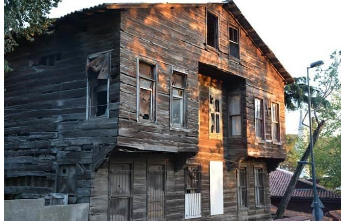
Şekil 7 Ahşap Duvar Örneği ( https://volkanatabey.com.tr/ahsap-yapi-malzemesi-hakkinda-bilgiler-avantajlari-ve-dezavantajlari/ (Erişim tarihi 26.06.2021))
