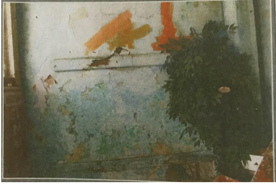
Fotoğraf 4 İstanbul-B y k ekmece 329 Ada 6 Parsel Zemin Kat Giri  G r n m 
