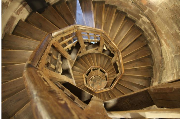
Şekil 13 Ahşap Merdiven ( https://pxhere.com/tr/photo/923550 Erişim tarihi 26.06.2021))
