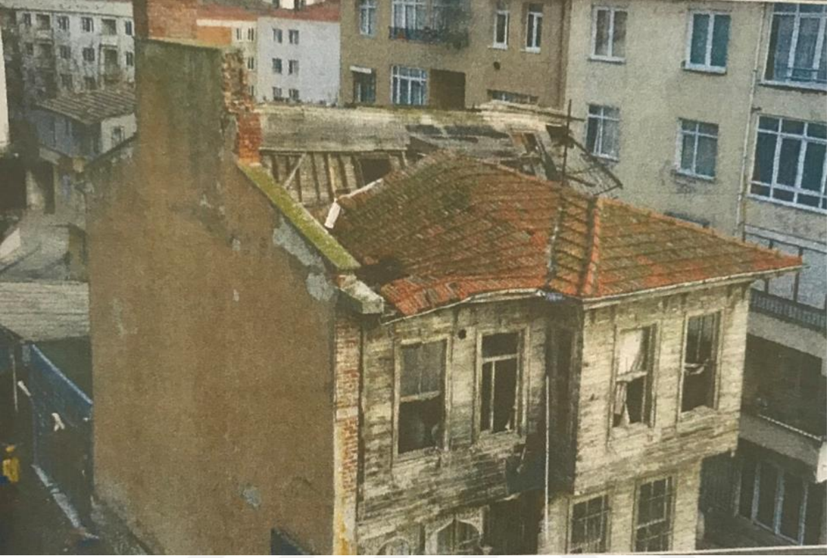
Şekil 24 Çatı Görünüşü (İstanbul-Büyükçekmece 329 Ada 6 Parsel) (Sezer, 2016)
