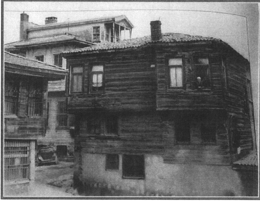
Resim 26: Eski Fotoğrafta Yer Alan Yapının Cihannüma ve Tuğla Baca-Baca Şapkası Görünümü
