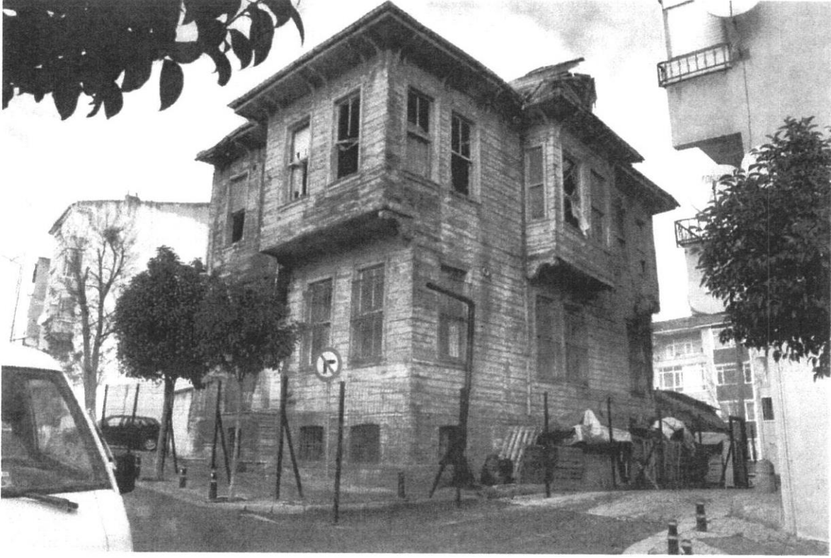
Fotoğraf 1 İstanbul-Büyükçekmece 329 Ada 6 Parsel Dış Görünüm
