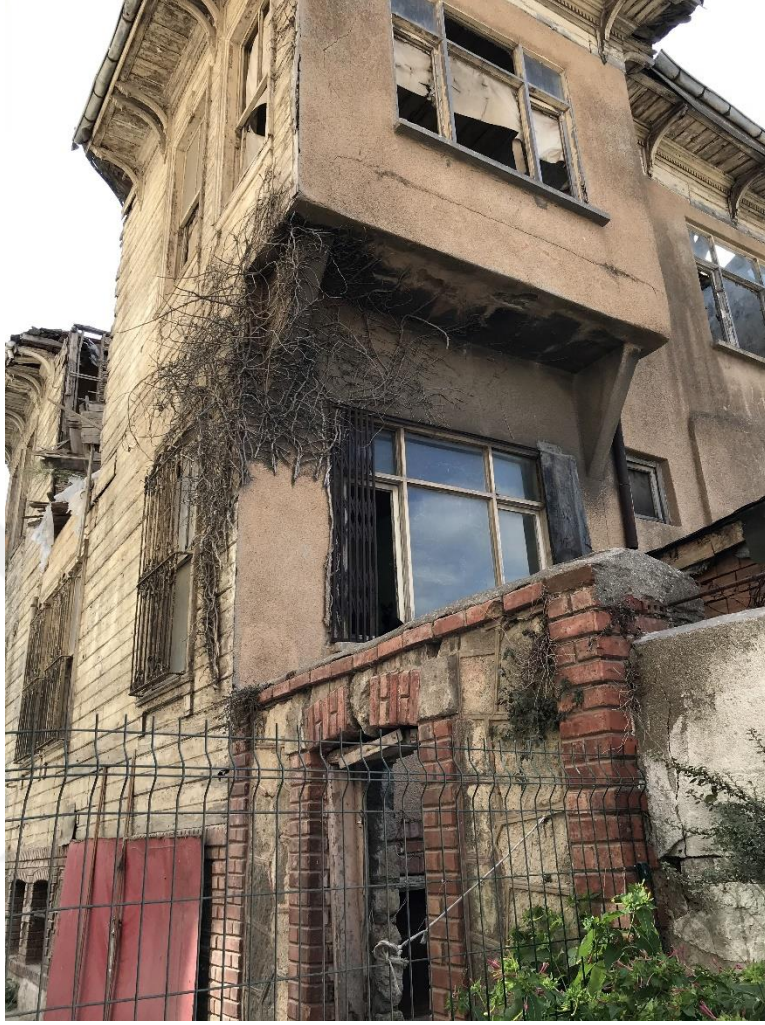
Fotoğraf 13 İstanbul-Büyükçekmece 329 Ada 6 Parsel Dış Görünüm
