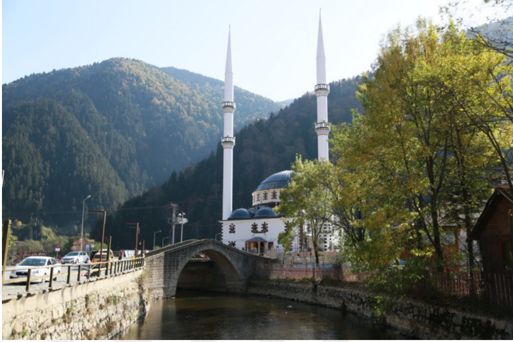
Şekil 3. 14. Uzungöl’deki tarihi kemer köprünün farklı açıdan görünümü (2020)
