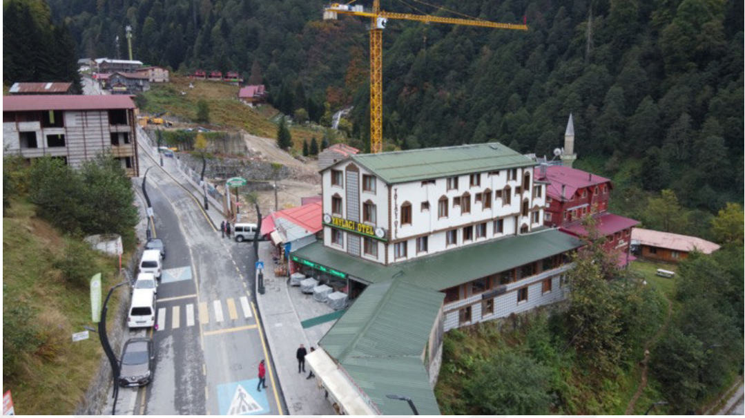
Şekil 3. 12. Ayder Yaylasındaki inşaat faaliyetlerinin görünümü (Kasım 2020)
