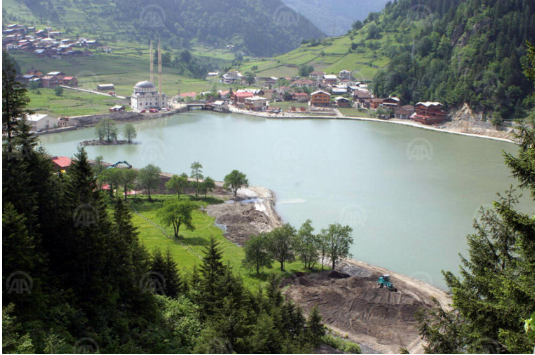
Şekil 3. 29. Uzungöl kıyı şeridinde iş makineleri çalışma esnasında görünüm (Anadolu Ajansı-2005)
