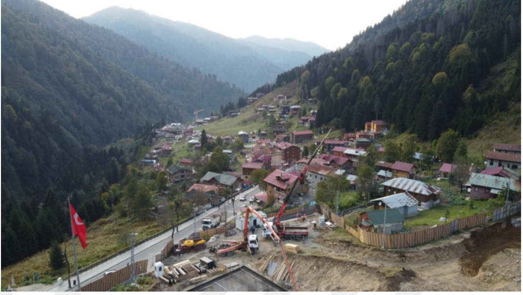
Şekil 3. 10. Ayder Yaylasındaki yapılaşma faaliyetlerinin görünümü (Kasım 2020)
