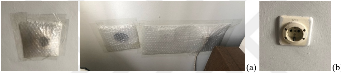
Şekil 3.12. 203 no'lu hacimde yapılan ölçümlerde (a) elektrik armatürlerinin sızdırmaz hale getirildiği, (b) elektrik armatürlerinin olduğu gibi bırakıldığı durum
