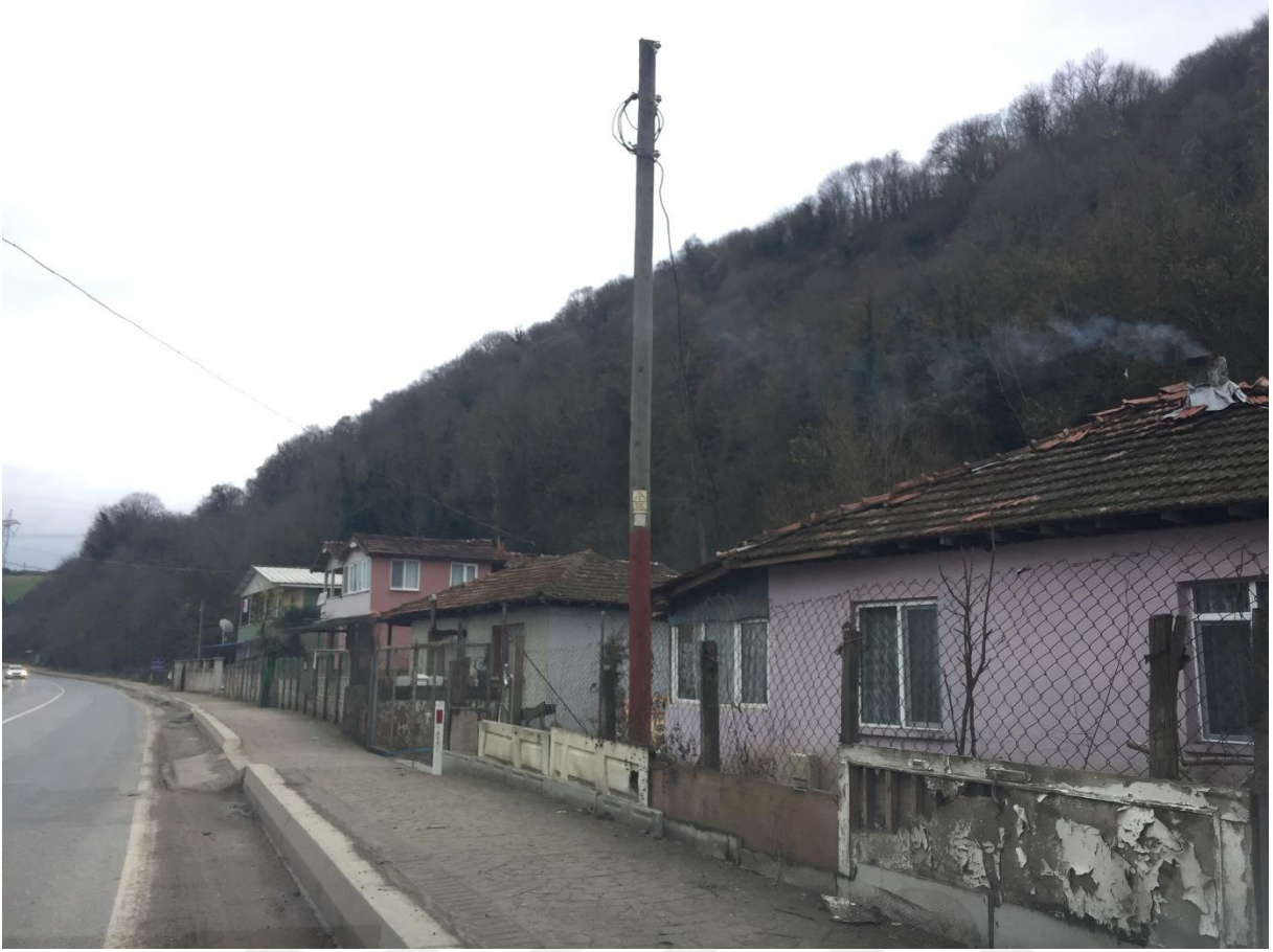
Fotoğraf 63: Kuruçeşme Mahallesi Kurtuluş Caddesinden Bir Görünüm
