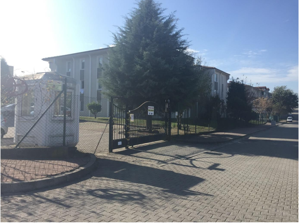
Fotoğraf 27: Beşköprü Mahallesi Toyota Caddesinde Yer Alan Toyota Evleri Sitesi
