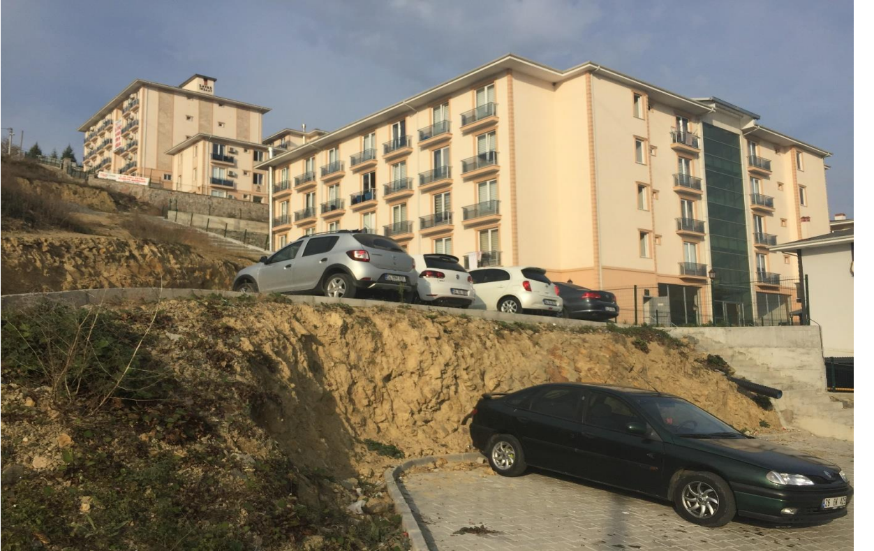
Fotoğraf 36: Kemalpaşa Mahallesi Üniversite Caddesi Üzerinde Eğitim Boyunca İnşa Edilen Yapılara Bir Örnek
