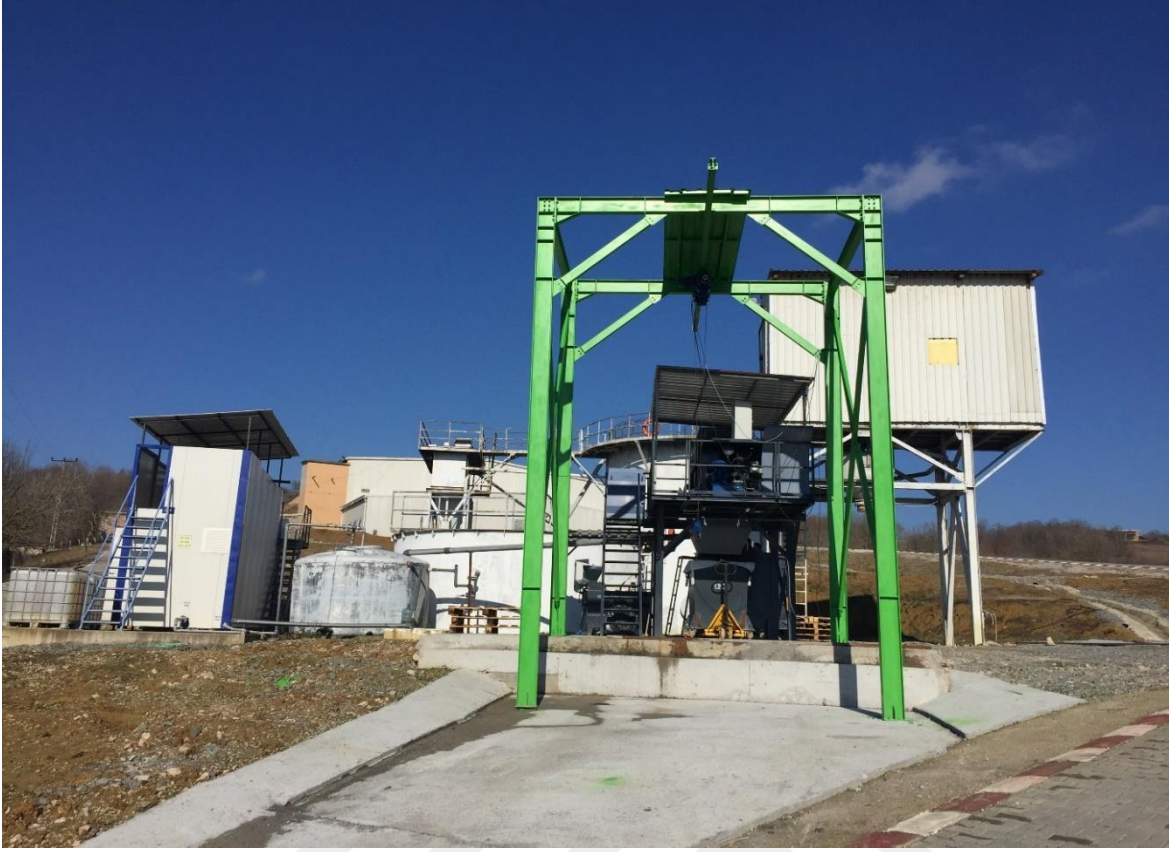
Fotoğraf 72: Beşevler Mahallesiindeki Şenpiliç Kuluçkahanesinden Bir Görünüm
