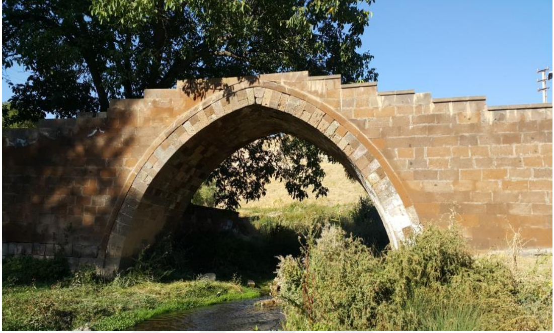
Şekil 2.6: Ahlat'ta Bulunan Bayındır Köprüsü (Tekin, 1998)
