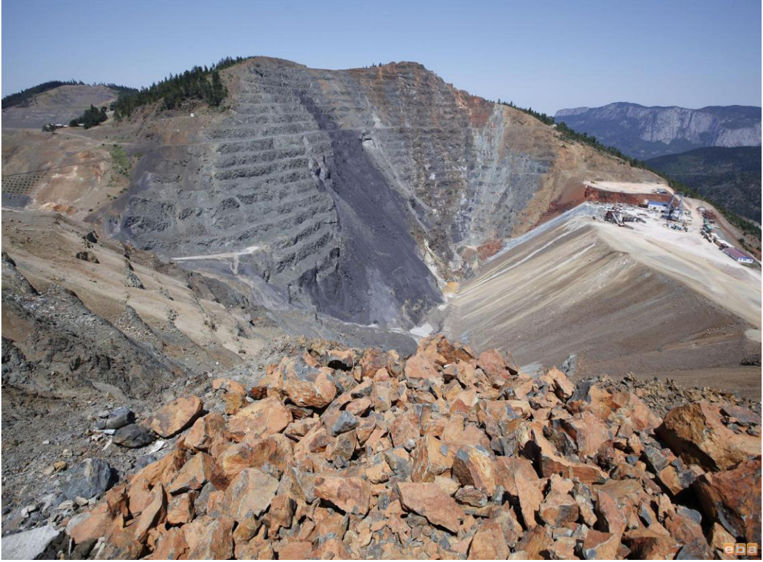
Şekil 2.8: Kastamonu-Küre Bakır madeni şev göçmesi (Huvaj, 2017).
