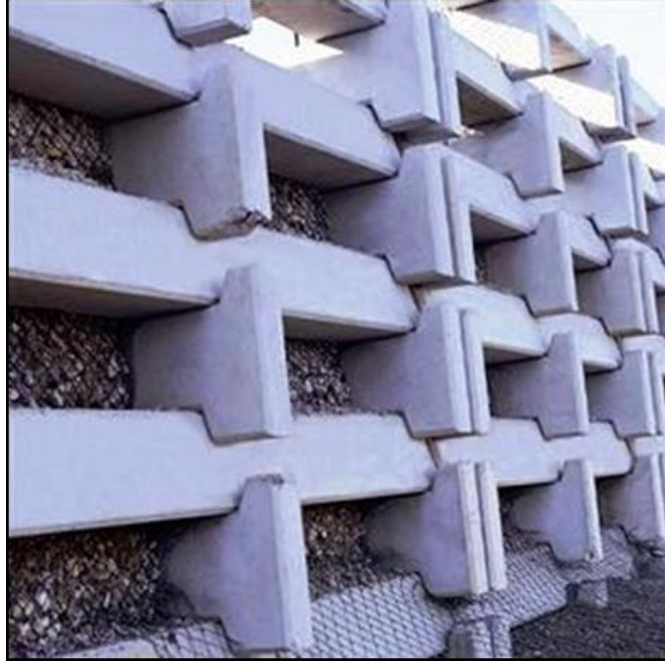
Şekil 4.14: Dolgulu çerçeve duvar (Tekin, 2011).
