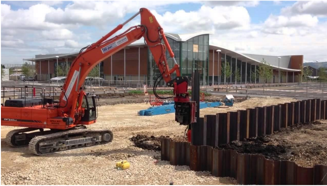
Şekil 4.16: Çelik palplanş uygulaması (Insapedia, 2018).
