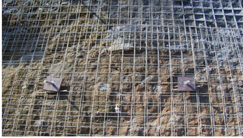
Şekil 4.24: Zemin çivisi uygulaması (Naturalzemin, 2016).
