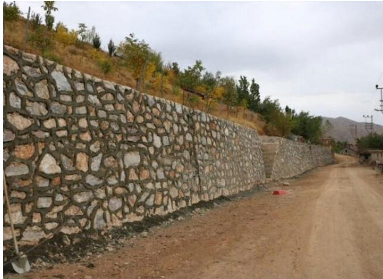
Şekil 4.12: Ağırlık istinat duvarı (Fermanoğlumetal, 2018).
