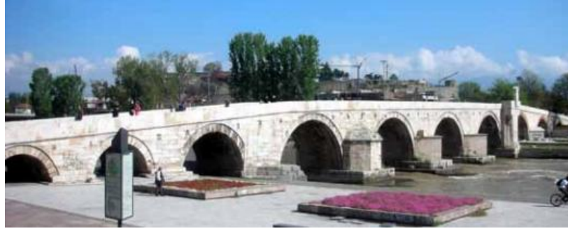
Şekil 3.18. Üsküp Fatih Sultan Mehmet Köprüsü
