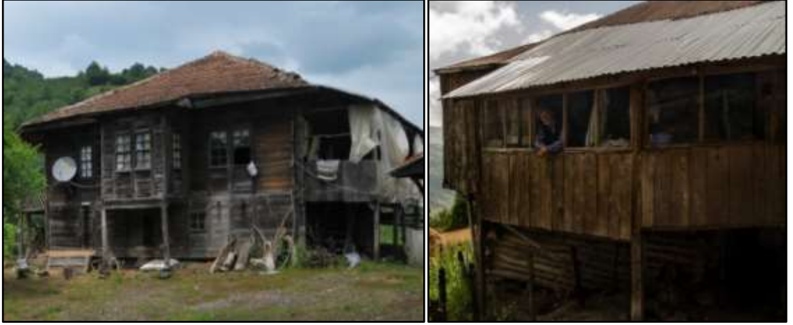
Fotoğraf 0.10. Akkuş İlçesindeki Ahşap Meskenlerden Görünüm
