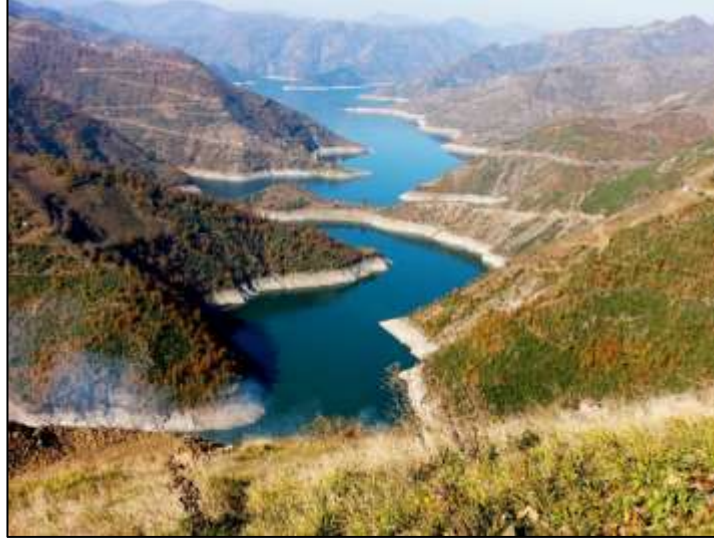
Fotoğraf 0.1. Akkuş İlçesi Hasan Uğurlu Baraj Göleti ( Foto: Akkuş Belediyesi)
