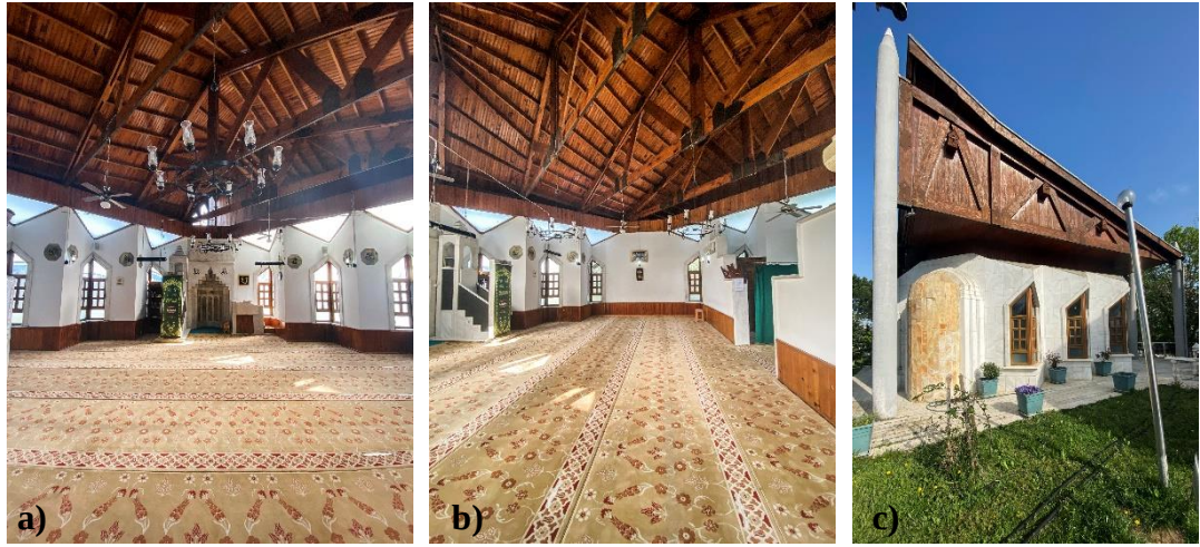
Şekil 3.148. a, b) Eyüp Yıldız Cami ahşap tavan, c) ahşap taşıyıcılar (Fotoğraf: Büşra Canbakış)
