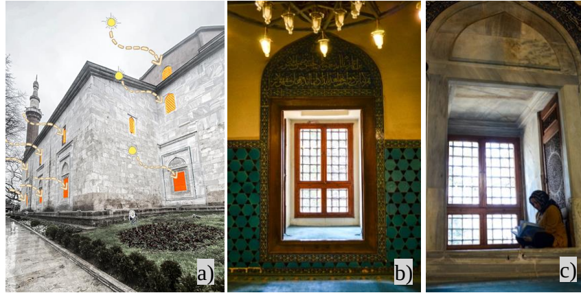
Şekil 3.51. Yeşil Cami pencereleri; a) gün ışığının üç farklı kotta yer alan pencereler sayesinde mekana alınması, b) zemin kat havalandırma ve aydınlatma amacı ile kullanılan pencere, c) duvar kalınlığından kaynaklı oluşan alanın değerlendirilmesi (Fotoğraf: Büşra Canbakış)
