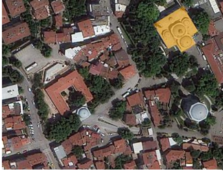
Şekil 3.52. Bursa Yeşil Cami Hava Fotoğrafı (Yandex 2019)
