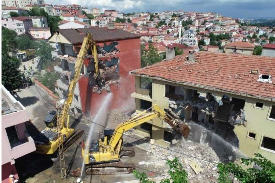
Şekil 4.22. Kirazlıtepe Mahallesi yıkımı (Fikirtepe Haber,2020)
