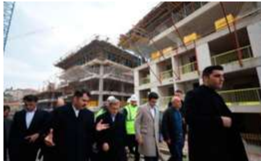
Şekil 4.24. Kirazlıtepe Mahallesi şantiye (Fikirtepe Haber, 2020)
