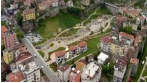
Şekil 3.41. Zağnos Vadisi görünüm (Emlak Eki, 2015)
