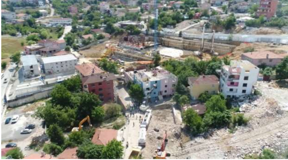
Şekil 4.21. Kirazlıtepe Mahallesi yıkımı (Fikirtepe Haber,2020)
