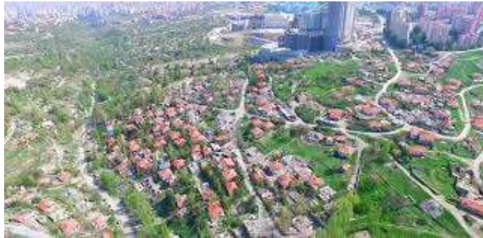
Şekil 3.32. Ankara Dikmen Vadisi eski vaziyet (İnsaat Deryası, 2020)
