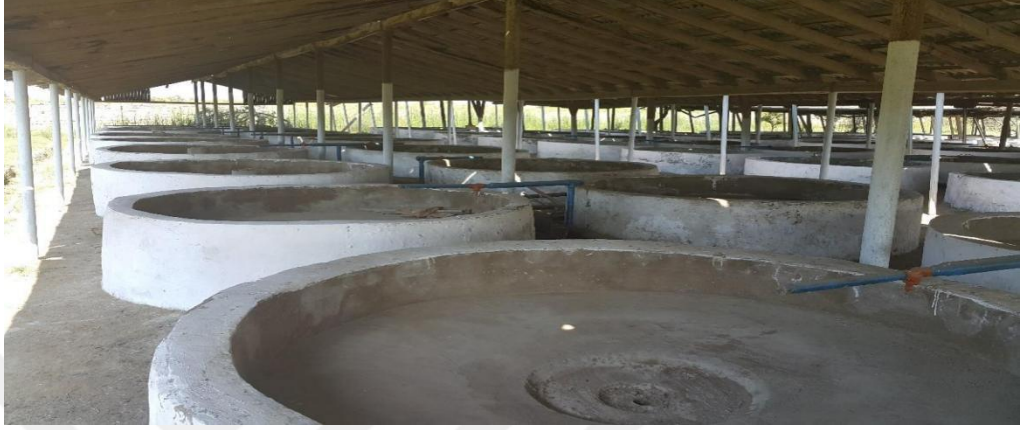
Resim 3.3. Azerbaycan'da Mersin Balığı yetiştiriciliğinde kullanılan sığ beton havuzlar (Kaynak: Özgür Altan).
