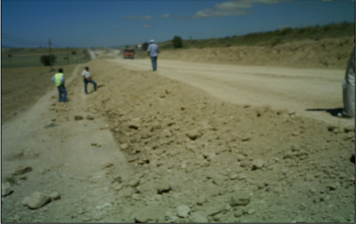
Resim 6.3. Kavşak yaklaşımında dolgu yapım işi
