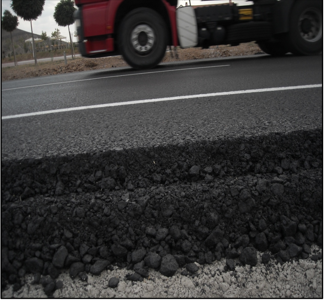
Resim 6.2. Kavşak kolu BSK tabakası(Binder, Bitümlü Temel)
