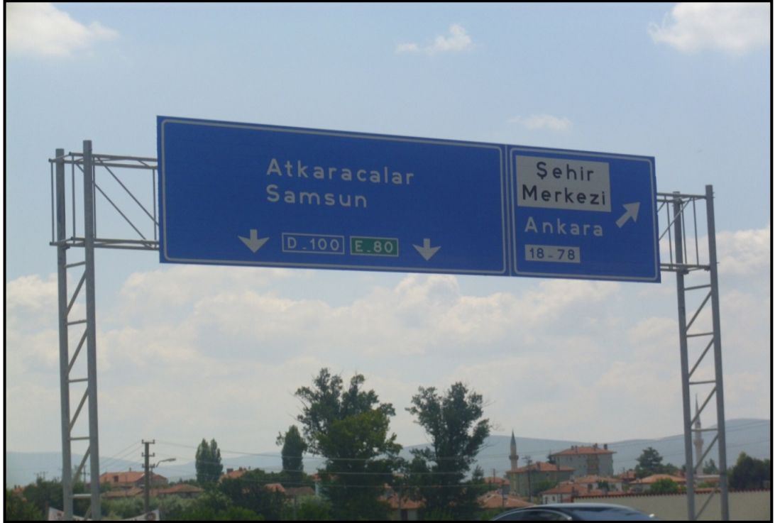
Resim 6.6. Kavşak yaklaşımı başüstü levha uygulamasına ait örnek
