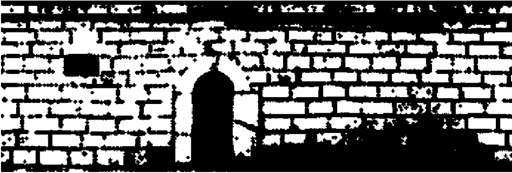
Şekil 4.21 : Strel (disk ,3) değeri 3 ile erozyon işlemi sonucunda oluşan binari görüntü.
