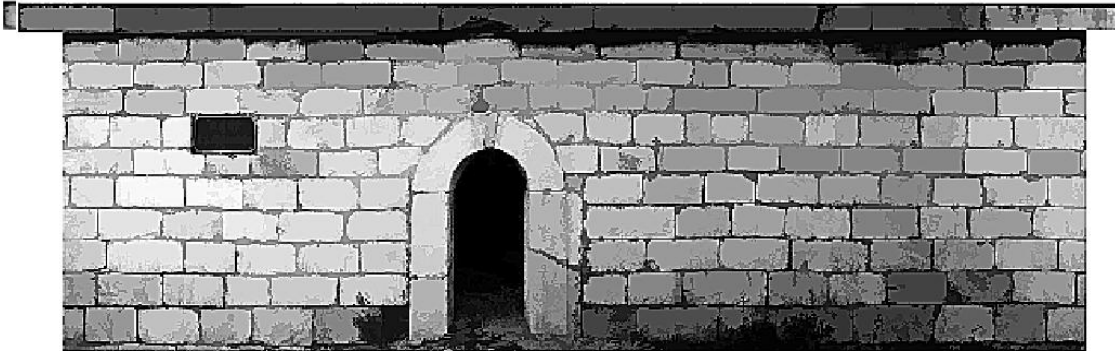
Şekil 4.24 : Açma kapama sonucunda oluşan görüntü üzerinden keskinleştirme filtresi geçirildikten sonra oluşan görüntü.
