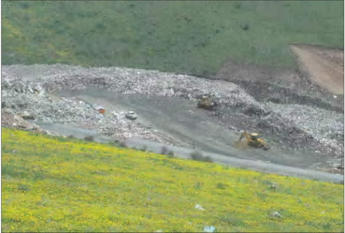
Şekil 7-2. Rehabilitasyon sonrası çöp depolama sahasına ait görüntüler
