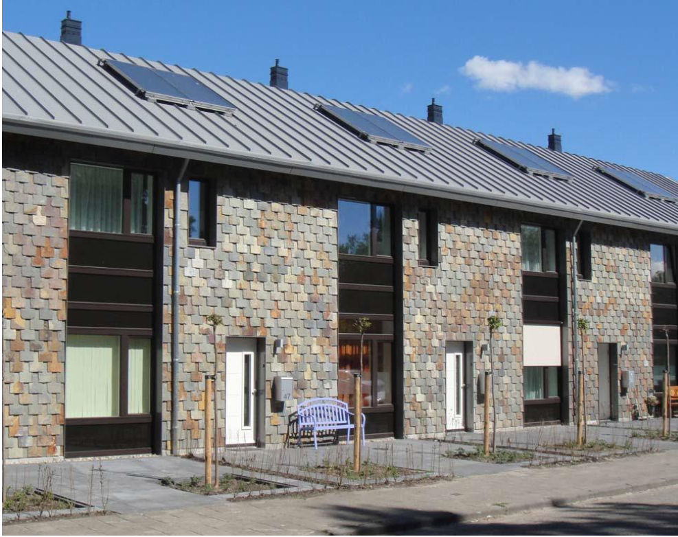
Şekil 3.9 : Hollanda Roosendaal yenileme çalışması sonrası (Zimmermann, 2011).
