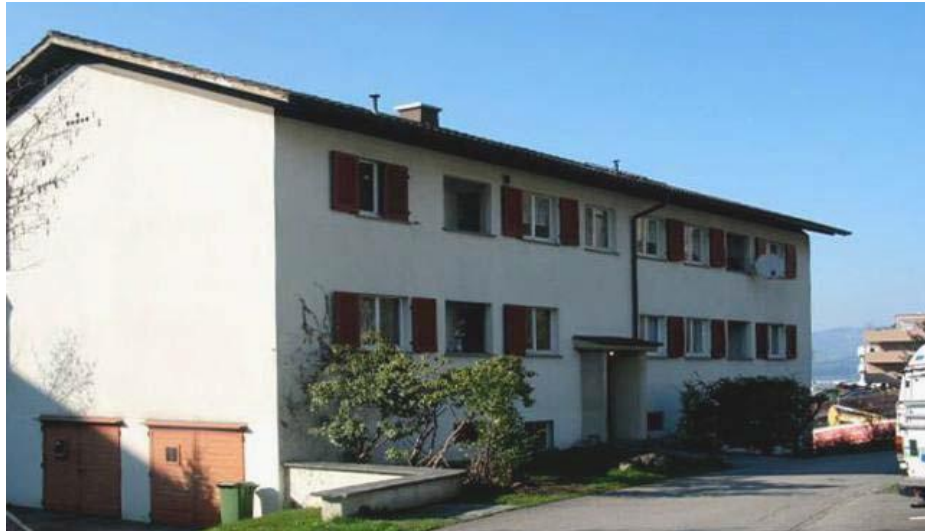
Şekil 3.2 : İsviçre Zug konut binası kuzeydoğu cephesi (Zimmermann, 2011).
