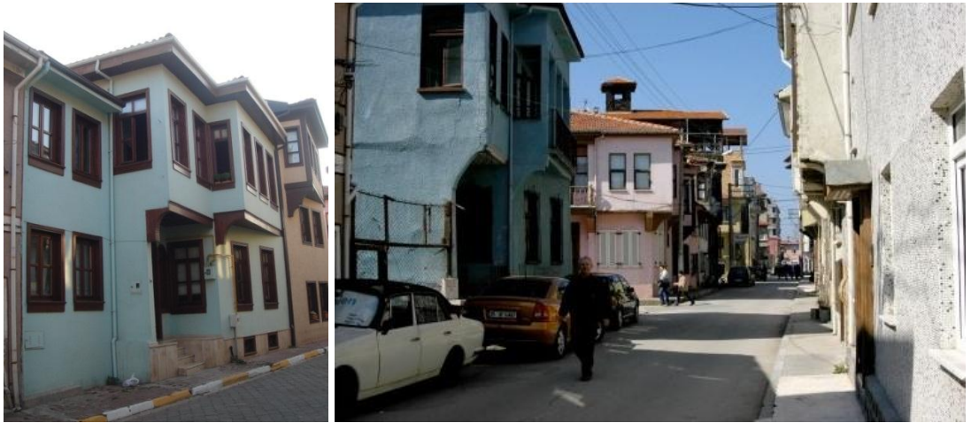
Şekil 4.30 : 4. Ada, 4. Parsel' de Bulunan Yapının Günümüzdeki (Şakir, 2013) ve Eski Hali (Anon).
