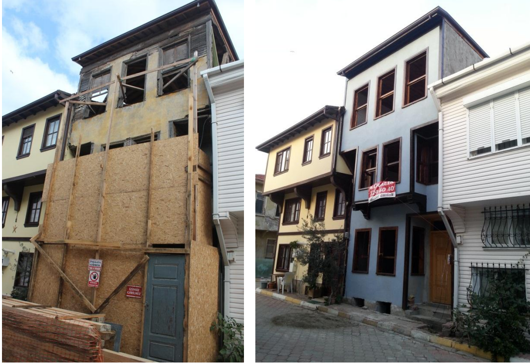
Şekil 4.57 : 3. Ada, 7. Parsel’ de Bulunan Yapının Restorasyon Öncesi ve Sonrası Durumu (Şakir, 2014).
