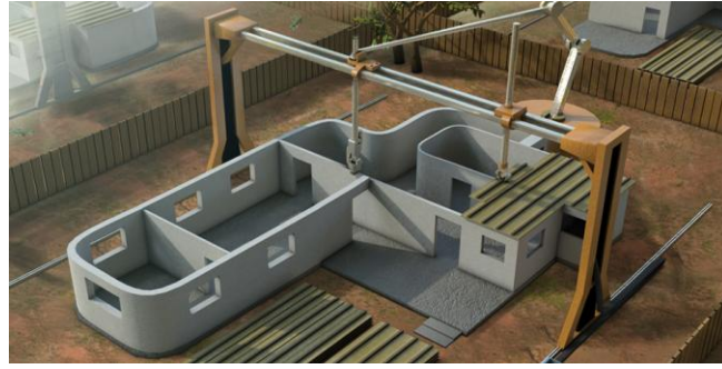
Şekil 2.23. Üç boyutlu yazıcı ile Contour Crafting tekniği kullanımı.
