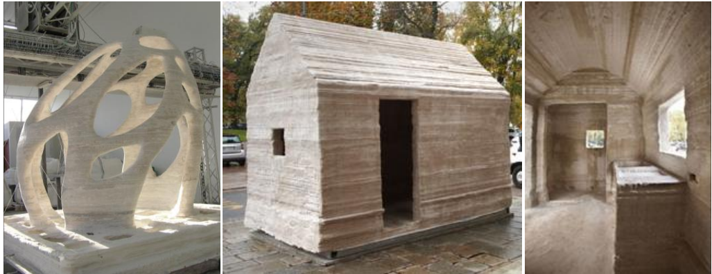
Şekil 2.22. D-Shape Üç Boyutlu Yazıcı ürünü Radiolaria (2009) ve Dağ Evi (2010).
