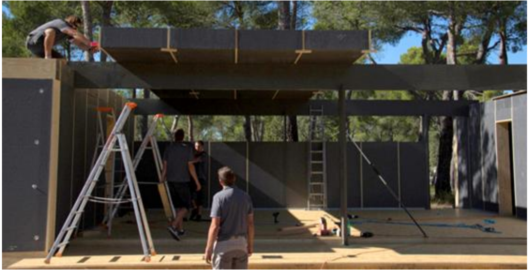
Şekil 4.44. Pop-up Ev, inşaat aşaması.
