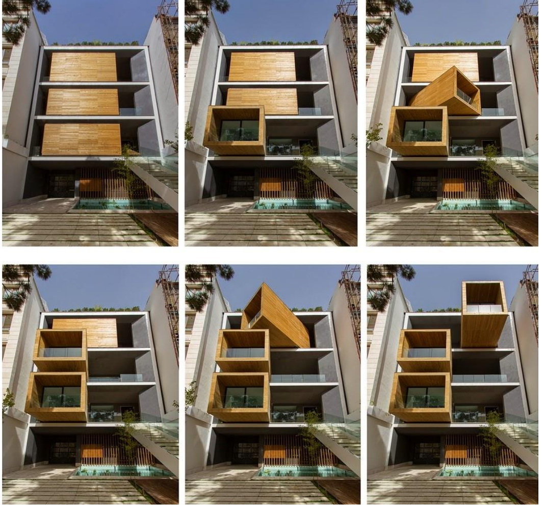
Şekil 4.54. Sharifi-Ha Evi Ön Cephe Görüntüsü: Modül birimlerin açık ve kapalı konumları.
