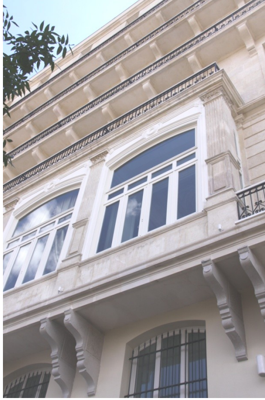
Şekil 5.127 : Pera Palas deniz cephesinde tekrarlı konsollar ve balkonlar.
