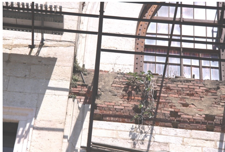
Şekil 5.277 : Tıbbiye deniz cephesinde dökme demir büyük kemerler.
