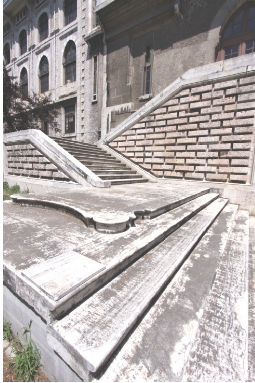
Şekil 5.264 : Tıbbiye'nin deniz tarafındaki kapısının merdivenleri.
