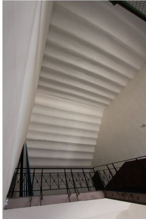
Şekil 5.275 : Tıbbiye binasında volta döşemeler.
