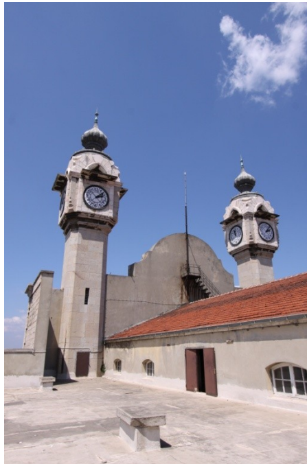
Şekil 5.225 : Tıbbiye'de gezilebilir çatı ve birimlere giriş.
