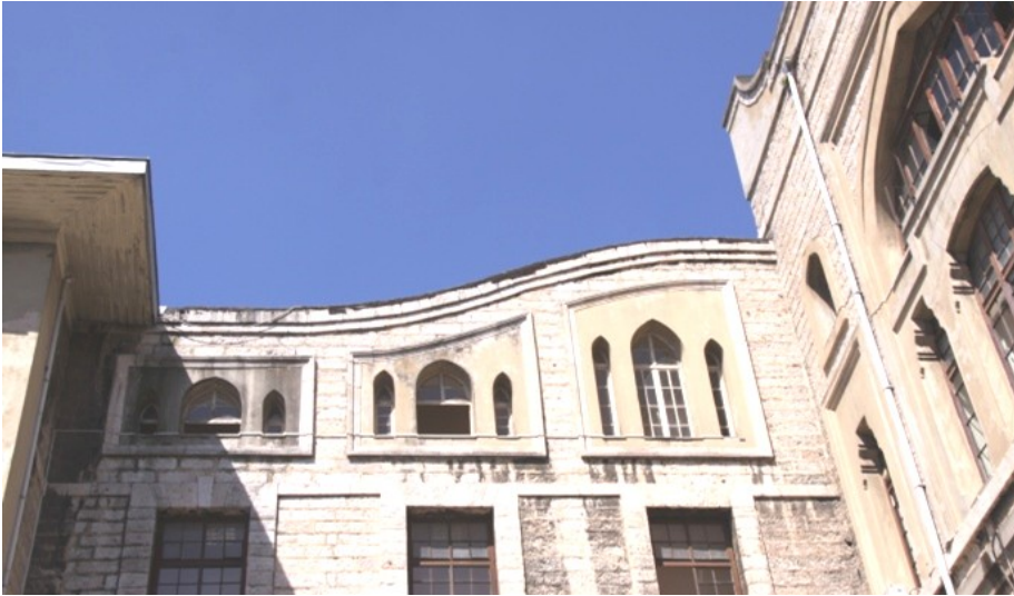
Şekil 5.232 : Tıbbiye'de çatı katı cephesi.
