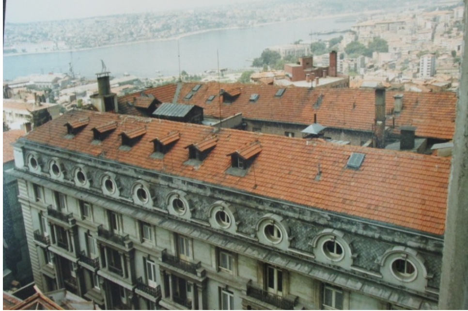
Şekil 5.100 : Pera Palas otelinin restorasyon öncesi çatı katlarının görünümü (KTVKK, 2013b).
