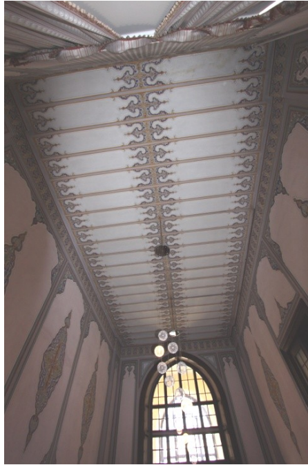
Şekil 5.263 : Tıbbiye binasında kalemişleri.
