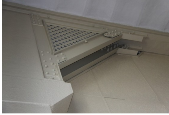
Şekil 5.287 : Tıbbiye binasında kulanılan demir köşebentlere bir örnek.
