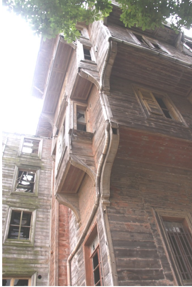
Şekil 5.198 : Prinkipo Palas cephesinde konsol ve çıkma kombinasyonuna örnek.
