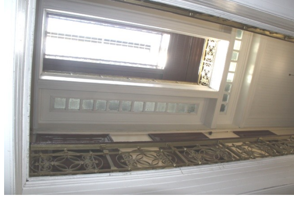
Şekil 5.141 : Düyun-u Umumiye binası koridor üzeri ışıklıklar.
