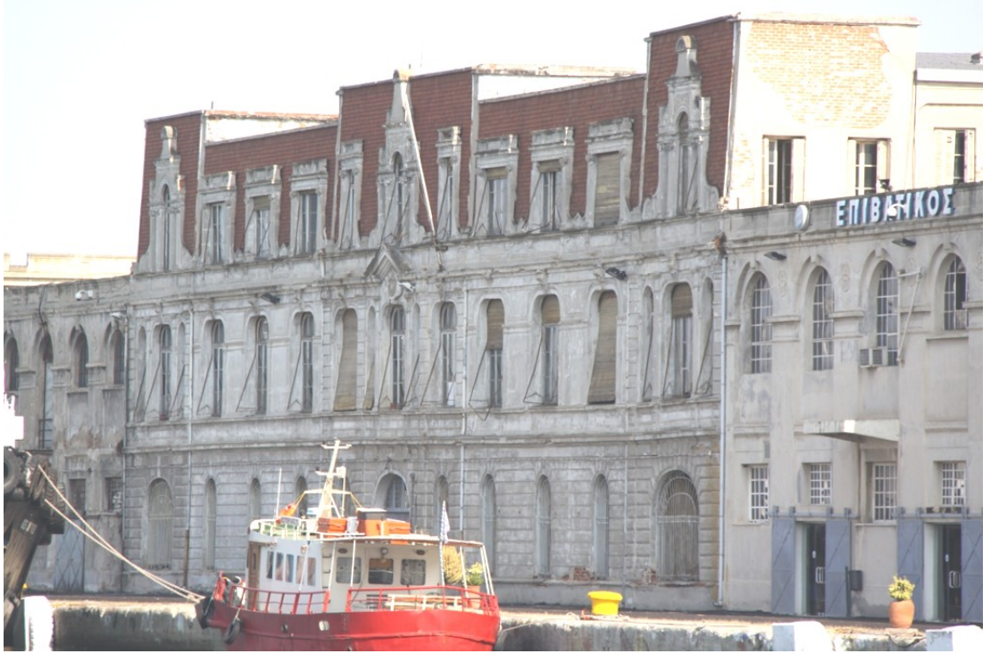
Şekil 5.303 : Selanik gümrüğü deniz cephesi.
