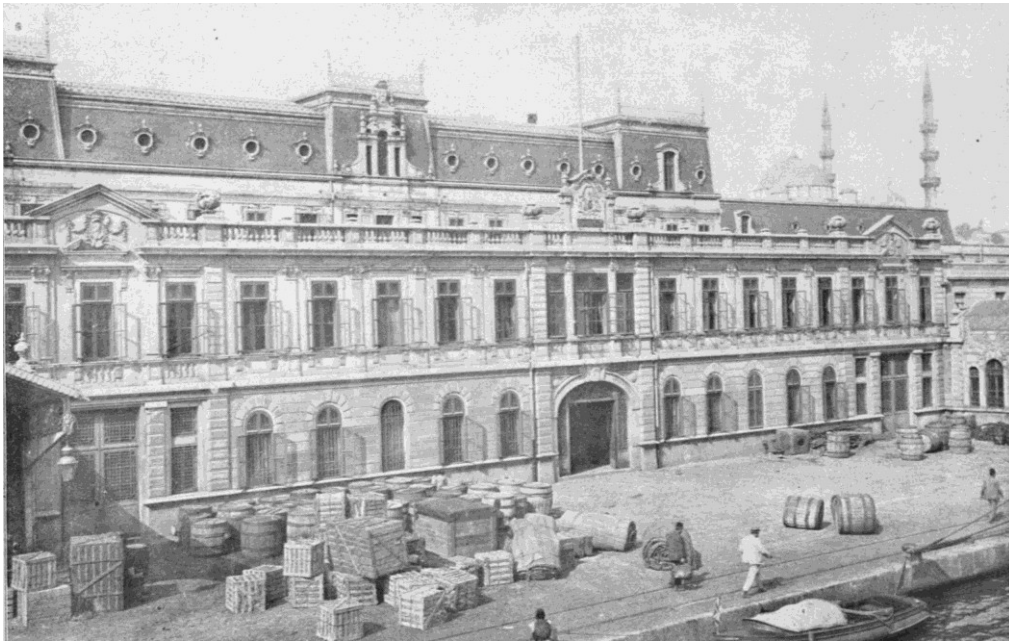
Şekil 5.289 : Eminönü gümrük binası deniz cephesi ("D-DAI-IST-R26459", t.y.).
