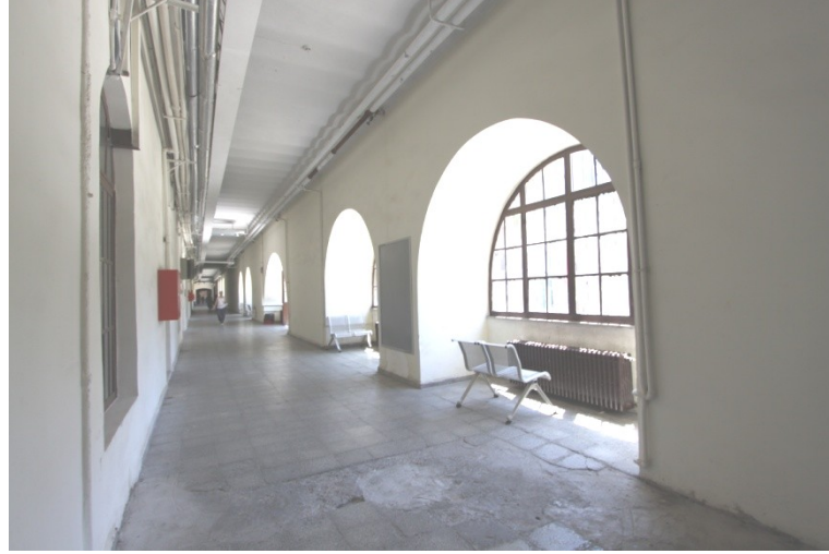
Şekil 5.276 : Tıbbiye binası bodrum katından bir görünüm.
