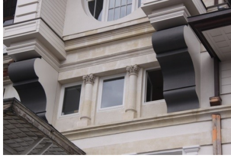
Şekil 5.83 : Osmanlı Bankası deniz cephesindeki büyük konsolları gösteren detay.
