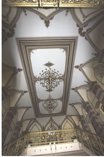
Şekil 5.222 : Tıbbiye hünkar dairesi tören holünde tonozlu üstyapı.
