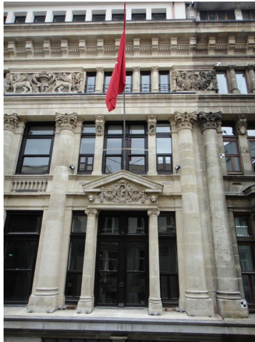
Şekil 5.79 : Osmanlı Bankası giriş cephesinden detay.
