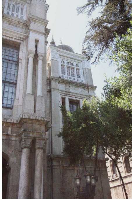
Şekil 5.259 : Tıbbiye binası kara cephesinden detay.
