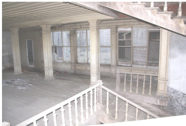
Şekil 5.194 : Prinkipo Palas oda katlarında ana merdiven holünden bir görünüm.
