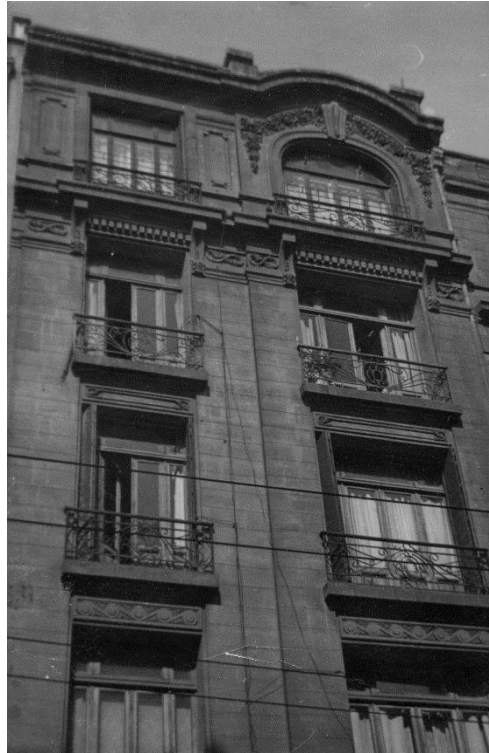
Şekil 6.39 :Edhem Bey'in Nouridjian'la beraber yaptığı Valikonağı caddesi No:77 («Valikonağı caddesi no:77 bina fotoğrafı», t.y.).
