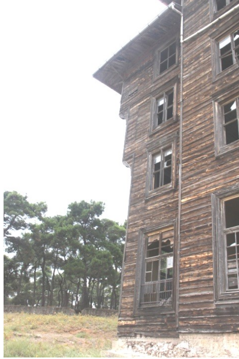
Şekil 5.203 : Prinkipo Palas'ta tekrarlı bindirilmiş konsollar.
