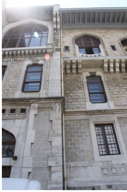
Şekil 5.163 : Düyun-u Umumiye binası cephesinde köşe taşları ve farklılaşan duvar dokusuna örnek.
