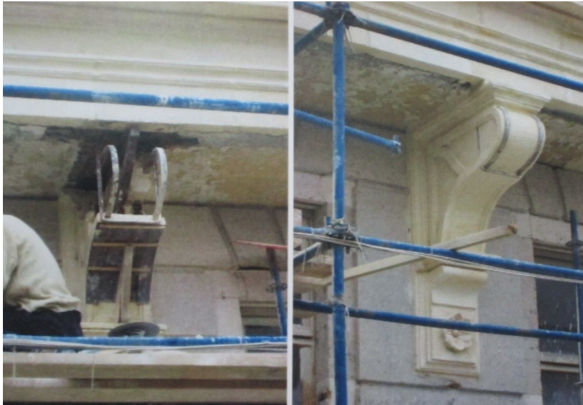
Şekil 5.120 : Pera Palas'ta cephe konsollarının restorasyonuna dair görüntüler (KTVKK, 2013b).
