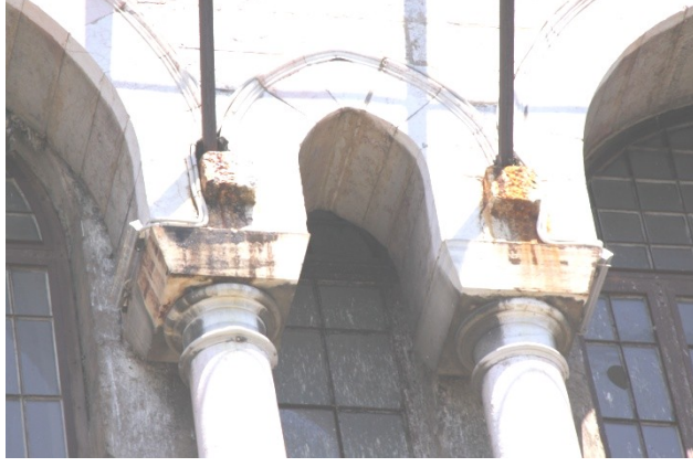
Şekil 5.283 : Tıbbiye binası deniz tarafında demir-taş bağlantı detayı.
