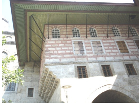
Şekil 5.151 : Bir onyedinci yüzyıl Osmanlı yapısı olan Yeni Cami'nin Hünkar Kasrı'nda kemer, konsol, saçak ve eliböğründeler.
