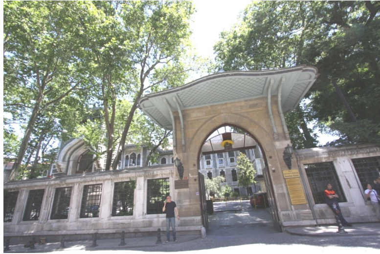
Şekil 5.146 : Düyun-u Umumiye binasının bahçe kapılarından biri ve arkada onunla aynı aksta olmayan ana giriş kapısı.
