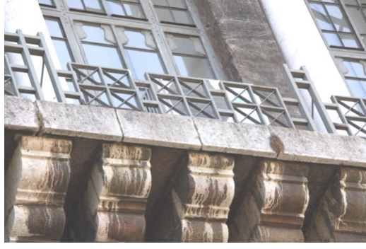
Şekil 5.239 : Tıbbiye deniz cephesindeki büyük boyutlu ve tekrarlı konsol taşları.
