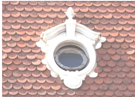
Şekil 5.310 : Selanik gümrüğü çatısında yer alan göz pencereler.
