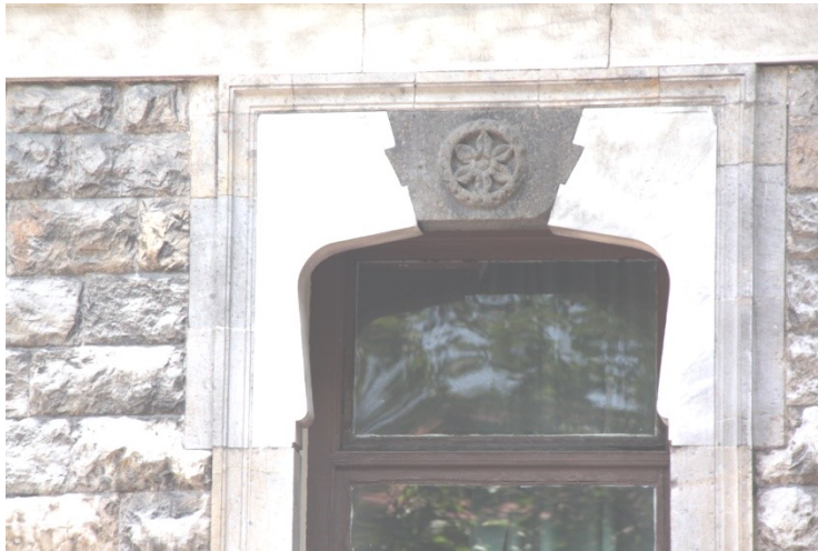
Şekil 5.170 : D yun-u Umumiye binası pencere s vesinde farklı kemer bi imi ve kemer ta ında g lbezek.
