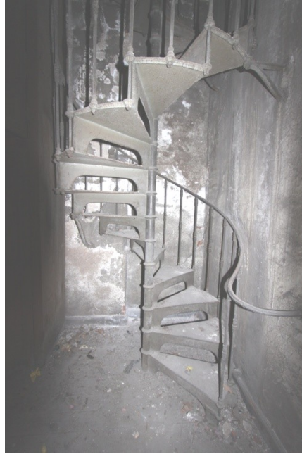
Şekil 5.144 : Düyun-u Umumiye binasında çatı dairelerine çıkan sarmal merdiven.
