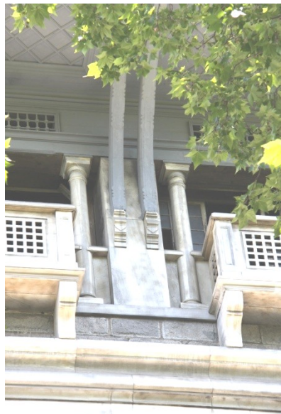
Şekil 5.167 : D yun-u Umumiye binası çatı katındaki odaların sa ak ve balkonları.
