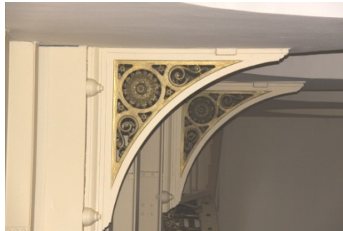
Şekil 5.242 : Tıbbiye binasındaki metal konsollar.
