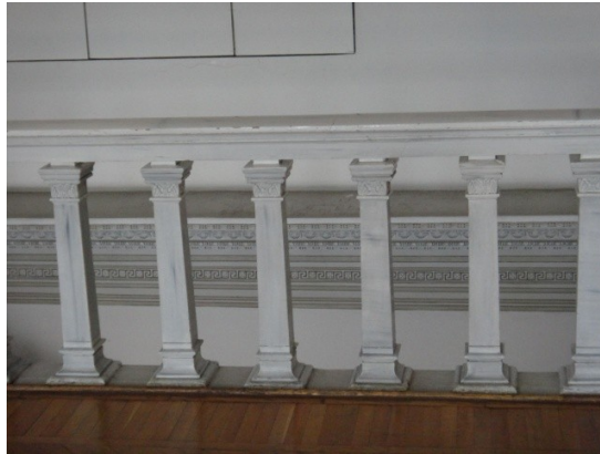
Şekil 5.28 : Müze binası birinci kısım ana girişteki merdivenin parmaklığı.
