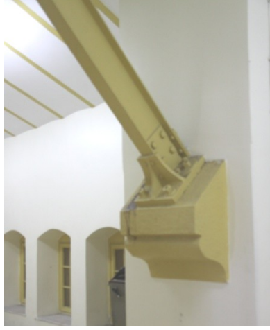
Şekil 5.284 : Tıbbiye çatı katında demir profil bağlantı detayı.
