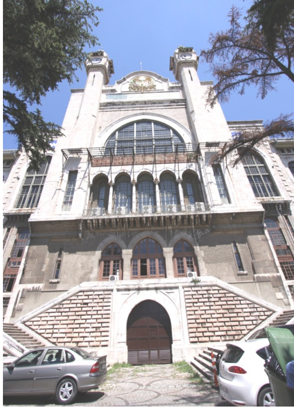
Şekil 5.227 : Tıbbiye'de deniz tarafında cami olan kısmın cephesi.
