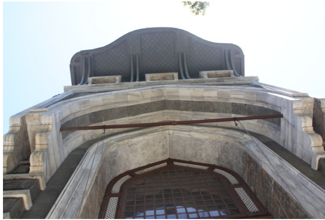
Şekil 5.148 : Düyun-u Umumiye binası taç kapı üstünde yeralan profil, saçak ve diğer mimari ögeler.
