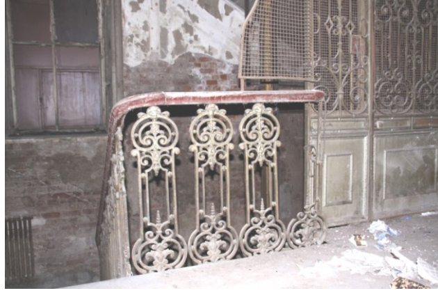
Şekil 5.59 : Cercle d'Orient merdiven parmaklığı detayı.
