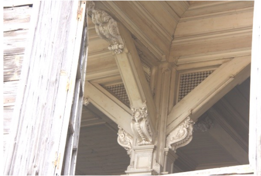
Şekil 5.204 : Prinkipo Palas tiyatrosunda ahşap taşıyıcıların detayı.
