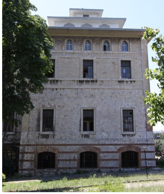
Şekil 5.220 : Tıbbiye'nin uçtaki bloğunun cephesi ve pencere düzeni.
