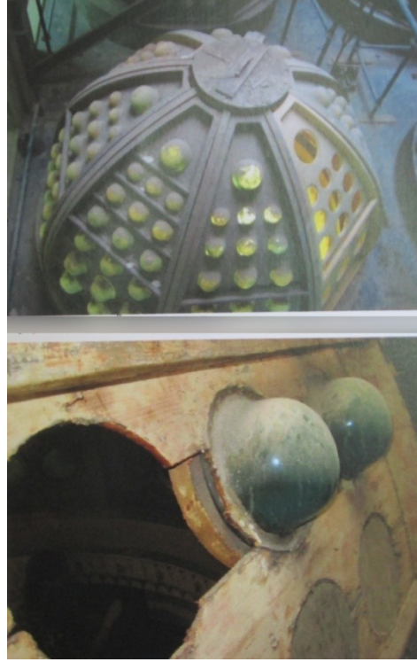
Şekil 5.119 : Pera Palas ana lobisine ait ahşap kubbeler ve detayları (KTVKK, 2013b).
