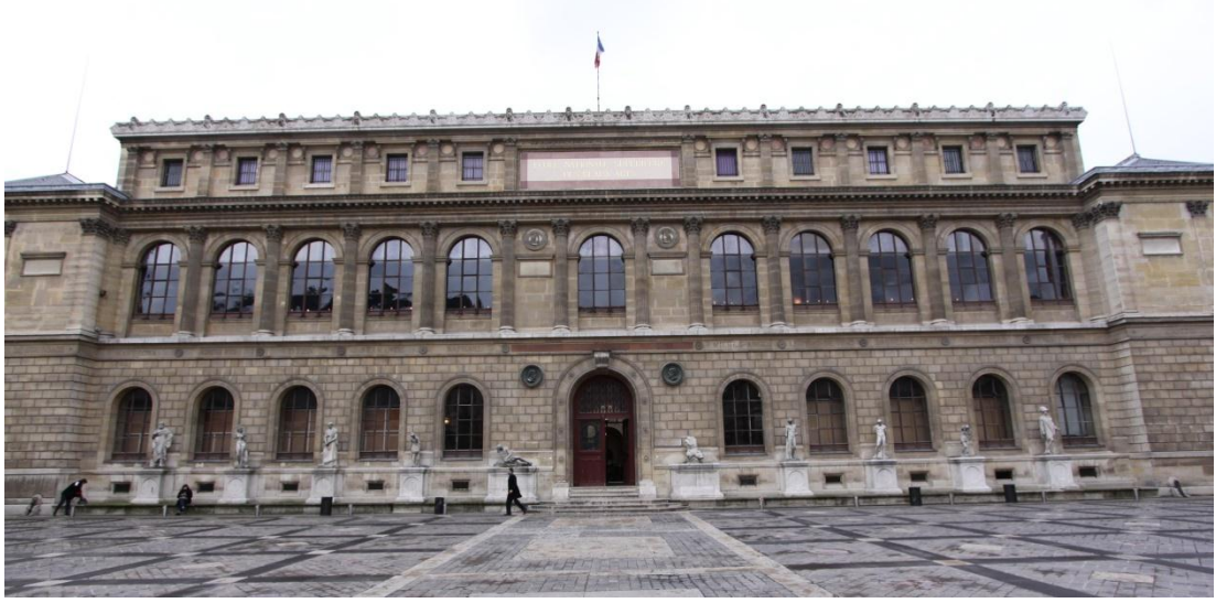
Şekil 3.12 : Palais des Études giriş cephesi.
