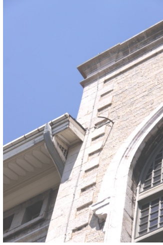
Şekil 5.261 : Tıbbiye cephesinde köşe taşları kullanımı.
