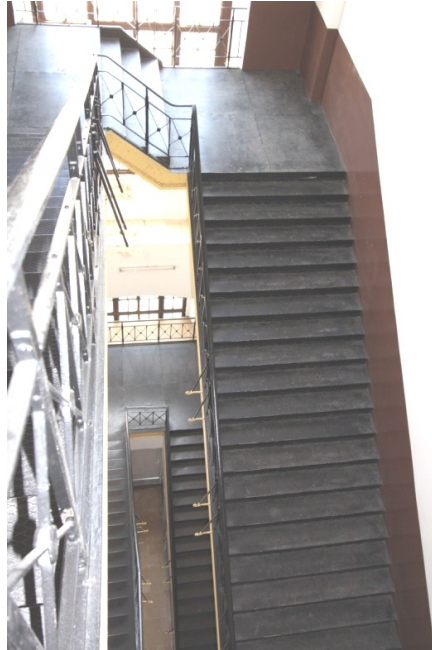
Şekil 5.280 : Tıbbiye binasında önyapım dökme demir merdivenler.
