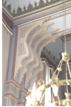
Şekil 5.241 : Tıbbiye binası hünkâr dairesindeki tekrarlı ahşap konsollar.
