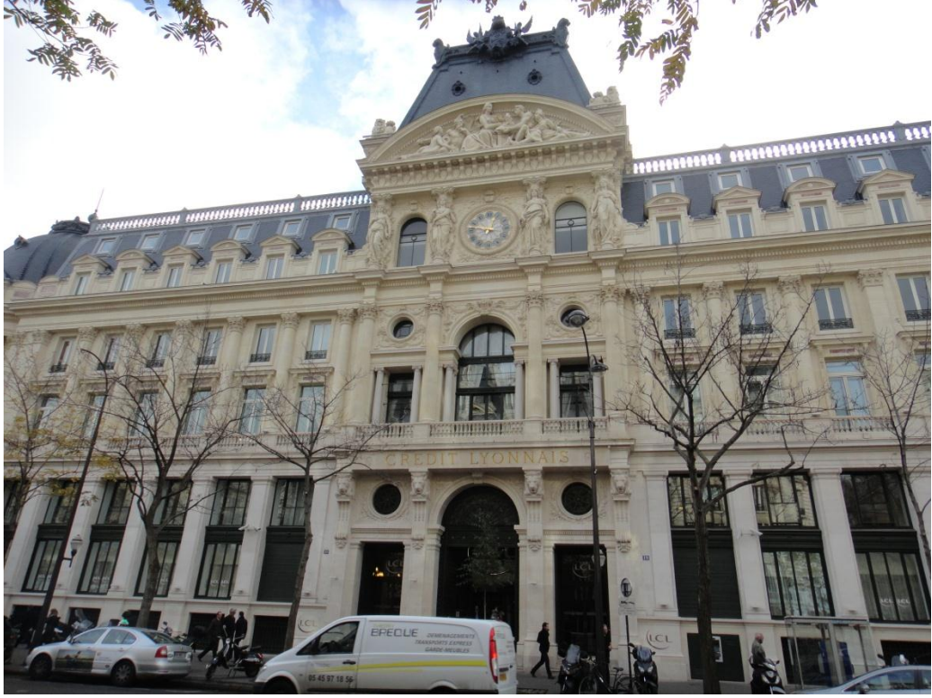
Şekil 3.21 : Crédit Lyonnais Bankası dış cephe.
