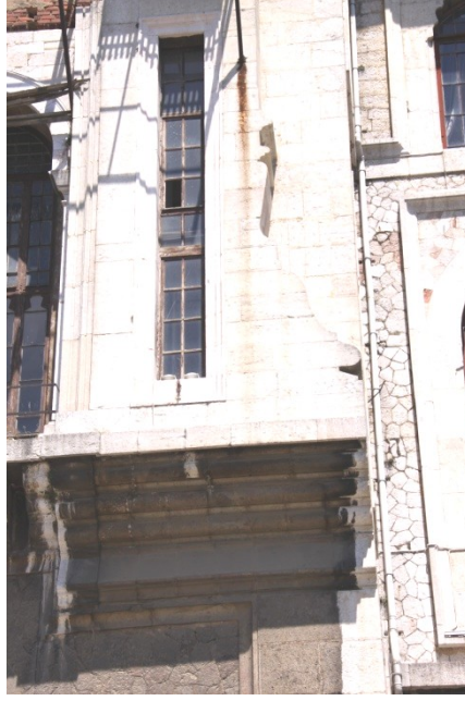
Şekil 5.248 : Tıbbiye binası cephesinden farklı taş dizilimi ve renklere sahip duvar dokusu örneği.
