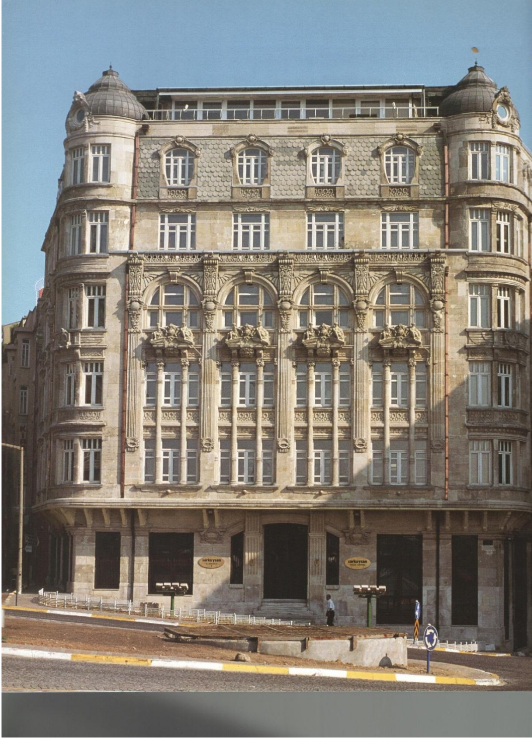
Şekil 6.28 : Şişhane Frej apartmanı (Colonas, 2005, s 40).
