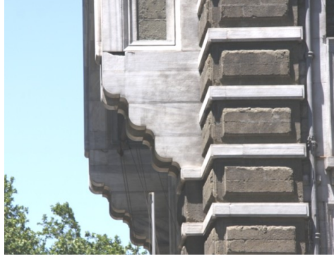
Şekil 5.149 : Düyün-u Umumiye giriş cephesindeki büyük konsol taşları.
