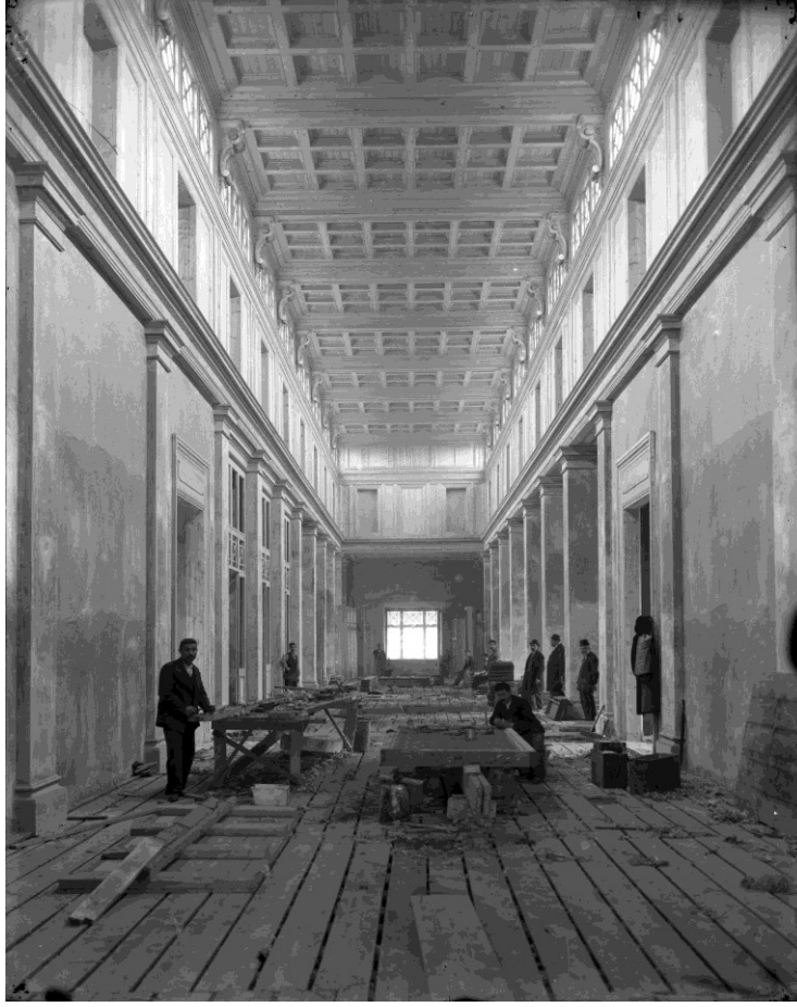
Şekil 5.22 : Müze birinci ek inşa halindeyken çekilmiş bir fotoğraf (“Müze-i Hümayun Birinci ek inşa halindeyken iç görünüş”, t.y.).
