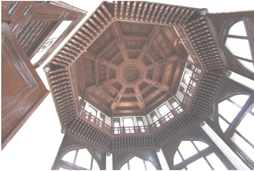
Şekil 5.160 : Düyün-u Umumiye binası Şeref Salonu ahşap çatısında örneği görülen tekrarlı ahşap konsollar.
