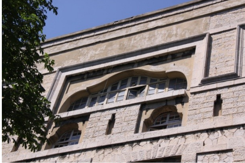
Şekil 5.272 : Tıbbiye binası çatı katında farklı pencere gruplamalarına örnek.
