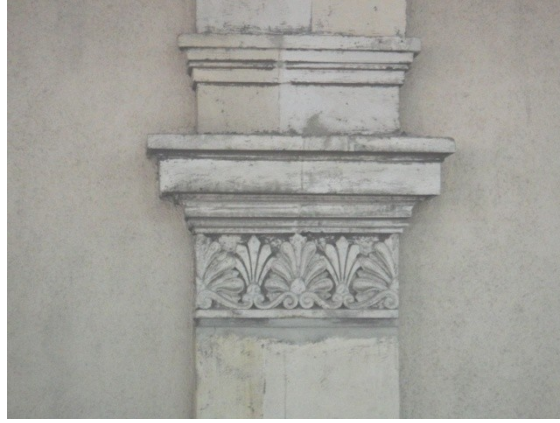
Şekil 5.20 : Müze cephesinden bir pilastıra ait detay.
