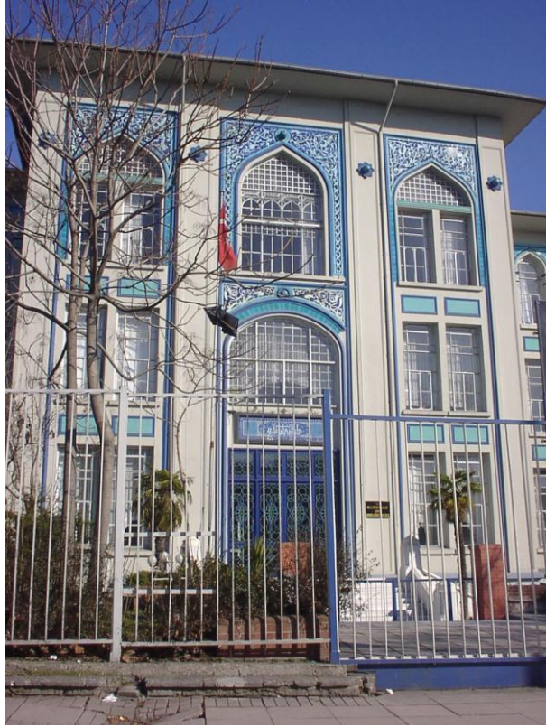
Şekil 6.27 : Makasdar ve Sauvegeot ile Çapa Dar-ül Muallimat binası (1912) (Darülmuallimat fotoğraf, t.y.).
