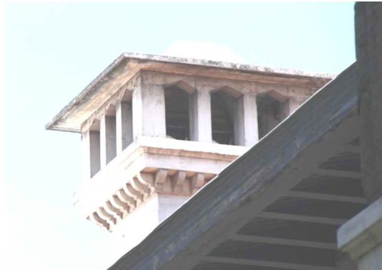
Şekil 5.177 : Düyun-u Umumiye binası bacalarından bir örnek.
