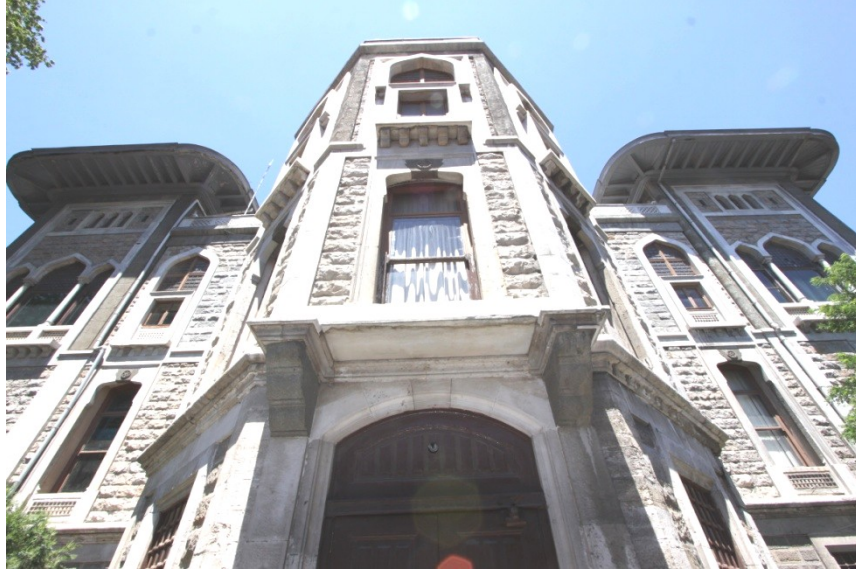
Şekil 5.154 : Düyün-u Umumiye binası yan cephesi.
