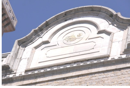
Şekil 5.253 : Tıbbiye binası eğrisel kalkan duvarlarından biri.
