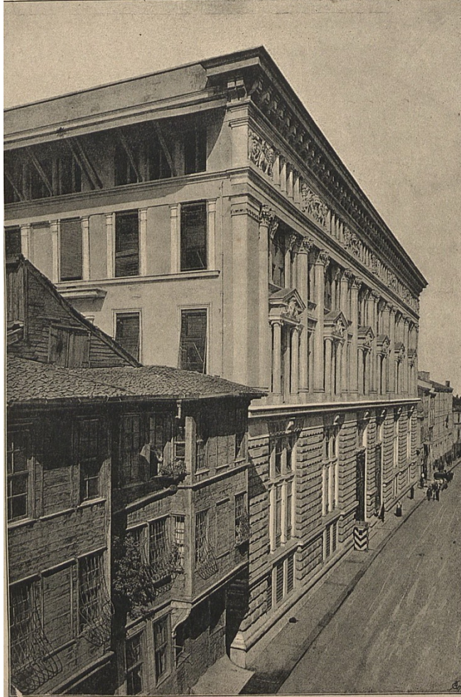
Şekil 5.64 : Osmanlı Bankası ve Reji İdaresi binasının sokak cephesi (“Osmanlı Bankasıyla Reji İdaresi binasının sokak cephesi”, 1892).
