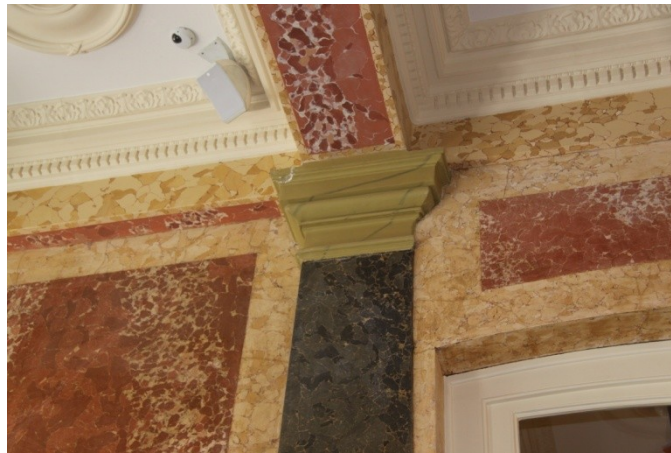
Şekil 5.122 : Pera Palas iç mekan bezemesinde stucco kullanımı.
