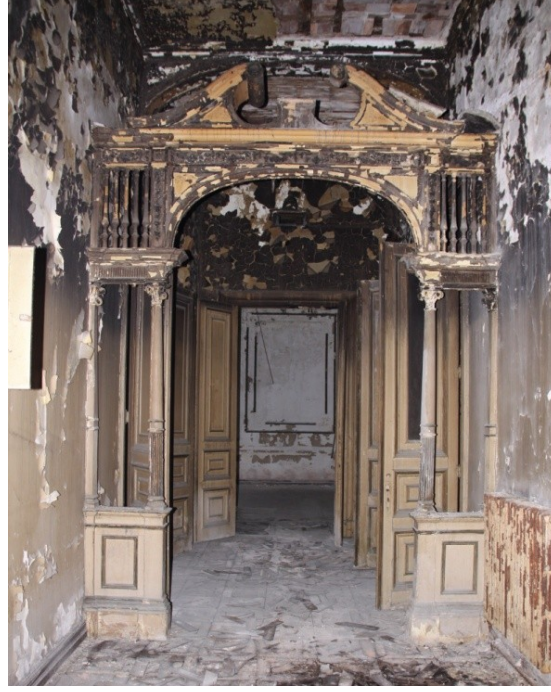
Şekil 5.56 : Cercle d'Orient koridor içi ahşap bölmelere örnek (Eyüpgiller, 2010).
