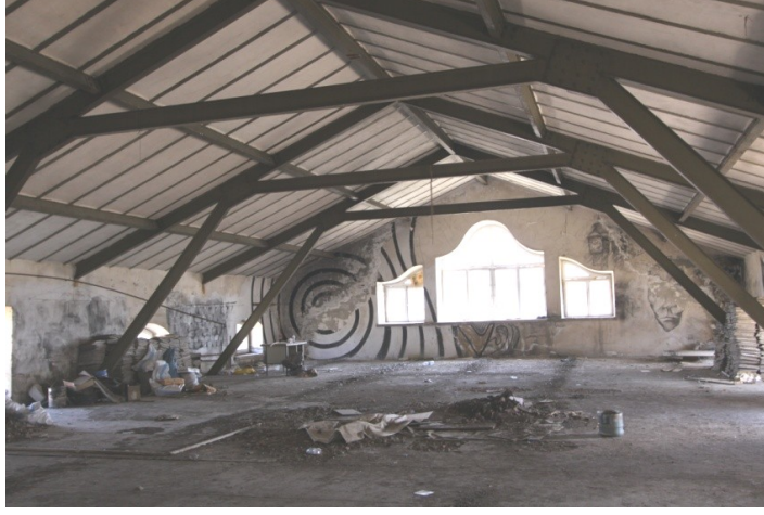
Şekil 5.278 : Tıbbiye binasında demir çatı strüktürü.
