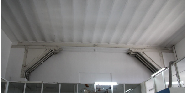
Şekil 5.279 : Tıbbiye binasında volta döşeme ve demir köşebentler.
