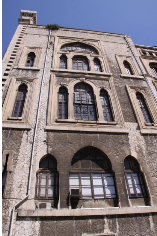
Şekil 5.270 : Tıbbiye binasında katlara göre farklılaşan pencere düzenleri ve üçlü gruplamalara örnek.
