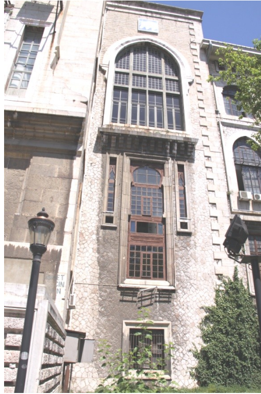
Şekil 5.249 : Tıbbiye binası deniz cephesinde farklı pencere söveleri ve duvar dokusuna örnek.
