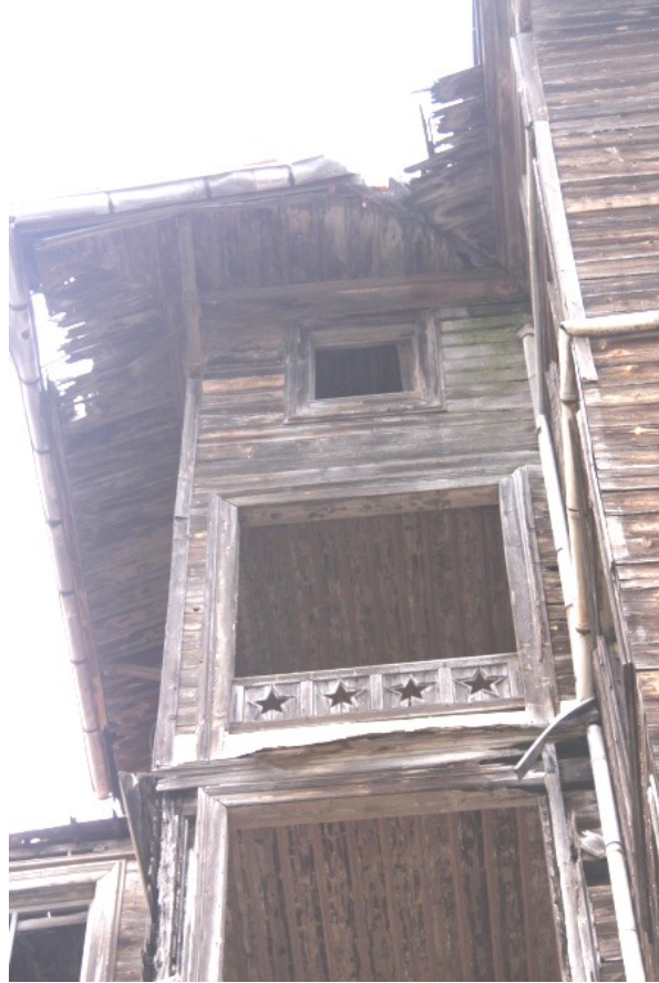
Şekil 5.205 : Prinkipo Palas balkonunda yıldız perforeli ahşap korkuluklar.
