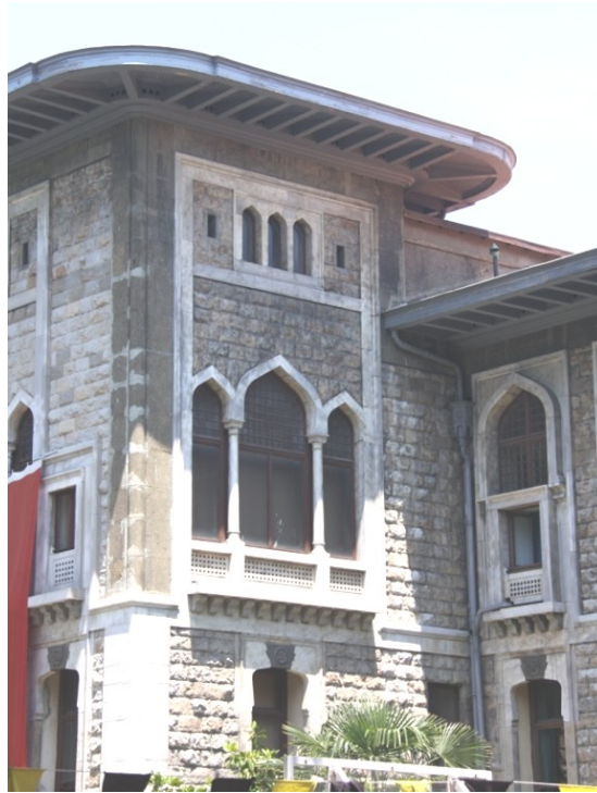
 ekil 5.172 : D yun-u Umumiye binasında   l  pencere grupları.
