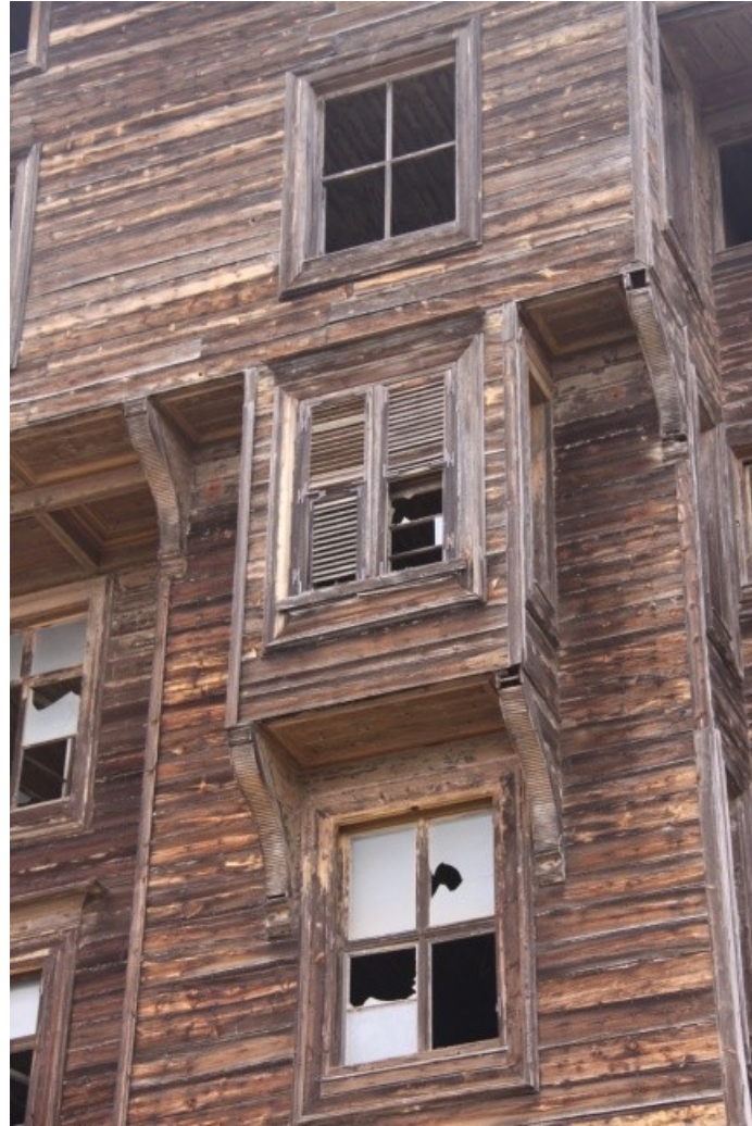
Şekil 5.201 : Prinkipo Palas'tan çıkma ve ahşap konsol örneği.
