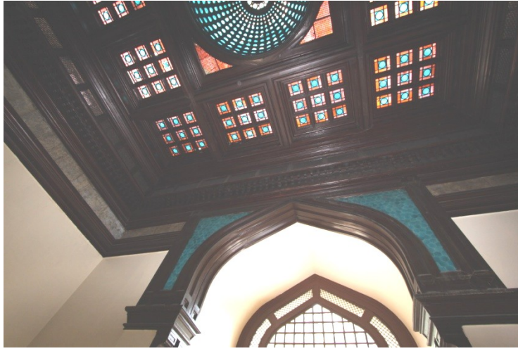
Şekil 5.169 : D yun-u Umumiye binası ana merdiven hol nde renkli vitray cam ve  ini kullanımı.
