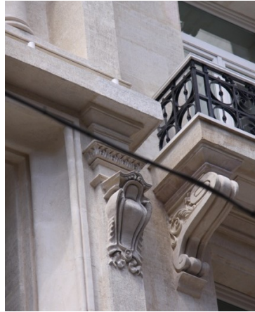
Şekil 5.115 : Pera Palas cephesinde kullanılan konsollardan örnek.
