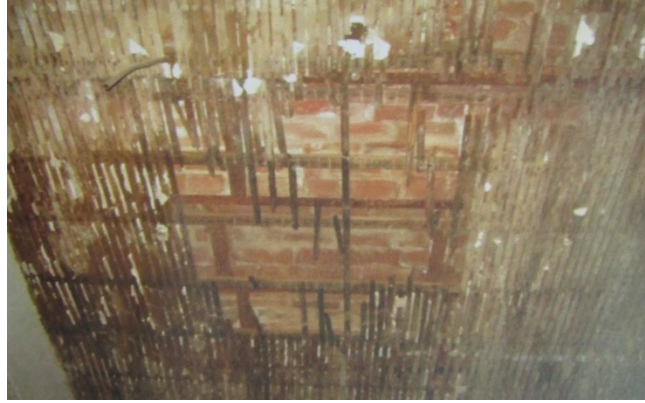
Şekil 5.117 : Pera Palas'ta kullanılan volta döşeme ve üzerini örten bağdadi tavan kaplaması (KTVKK, 2013b).
