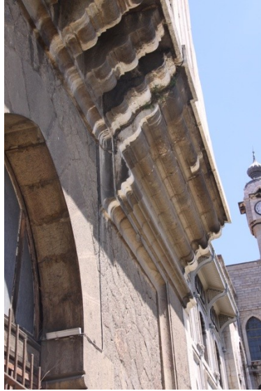
Şekil 5.238 : Tıbbiye binası cephesindeki konsol taşları.
