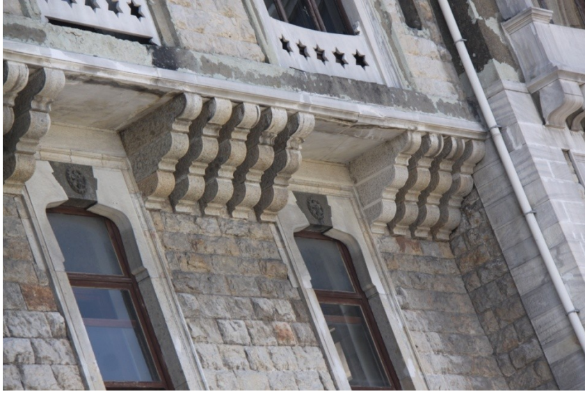
Şekil 5.159 : Düyün-u Umumiye binası cephesinde sıkça kullanılan tekrarlı ve dilimli konsol taşları.
