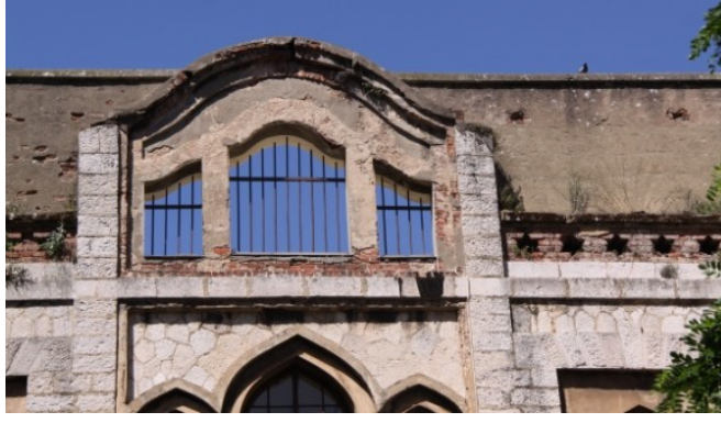
Şekil 5.236 : Tıbbiye çatısında eğrisel kalkan duvar ve yıldız perforeli parapet.
