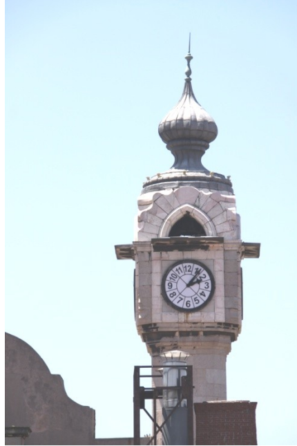
Şekil 5.246 : Tıbbiye binası deniz kanadındaki saatli ikiz kuleciklerden biri.
