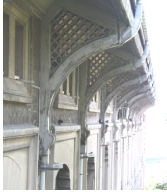
Şekil 5.240 : Tıbbiye binası saçak altındaki ahşap tekrarlı konsollar.
