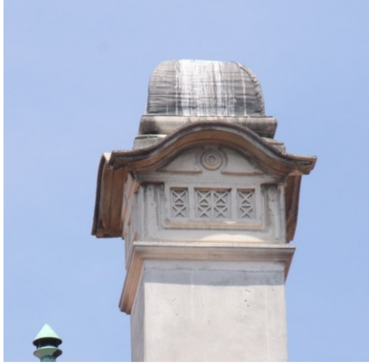
Şekil 5.176 : Düyun-u Umumiye binası bacalarından bir örnek.
