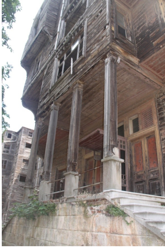
Şekil 5.189 : Prinkipo Palas kara tarafındaki sundurmalı giriş kapısı.
