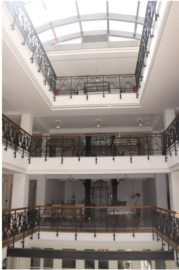
Şekil 5.103 : Pera Palas oteli içi aydınlık boşluğu ve galeriler.
