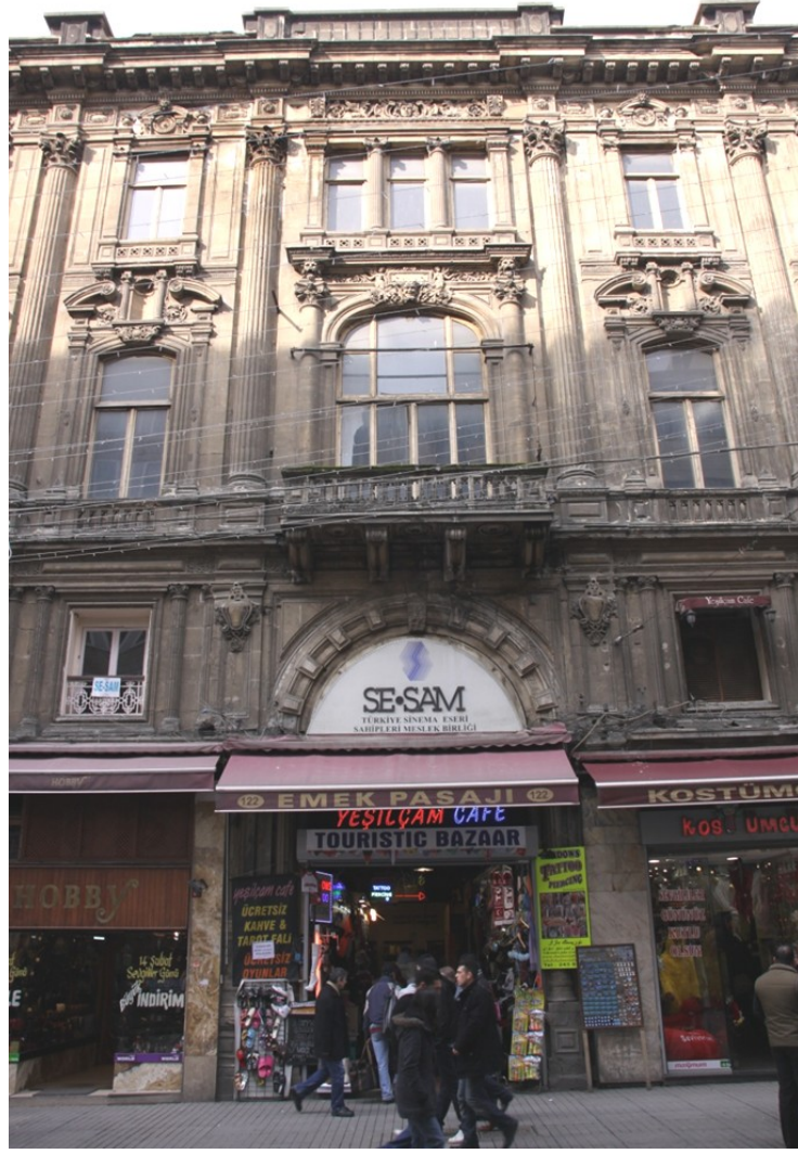
Şekil 5.48 : Cercle d'Orient binası giriş cephesi.
