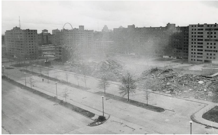
Şekil 3.1: Pruitt-Igoe'nun yıkımı (Url-1)
