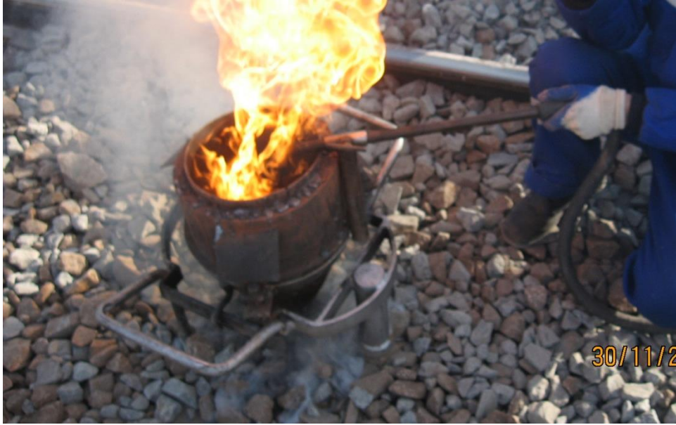
Şekil 4.19: Potanın döküme hazırlanması
