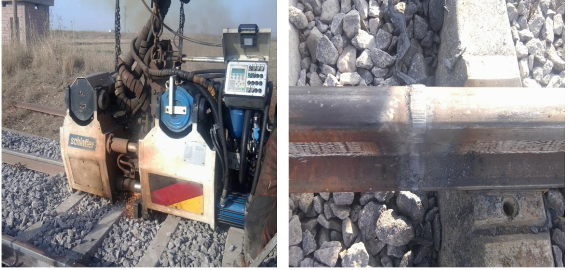
Şekil 5.3: (+22°C)'de kaynaklanmış rayların kaynak anında çekilmiş fotoğrafları
