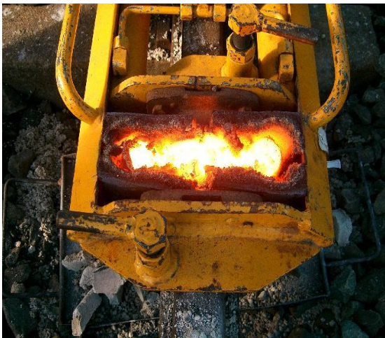
Şekil 4.25-a) Kaynak bölgesinin sıyrılması, b) Kaynak bölgesinin sıyrılması
