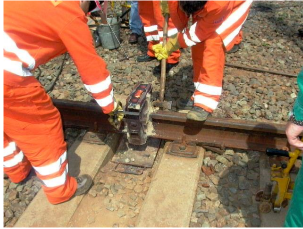
Şekil 4.24: Kalıpların çıkartılması
