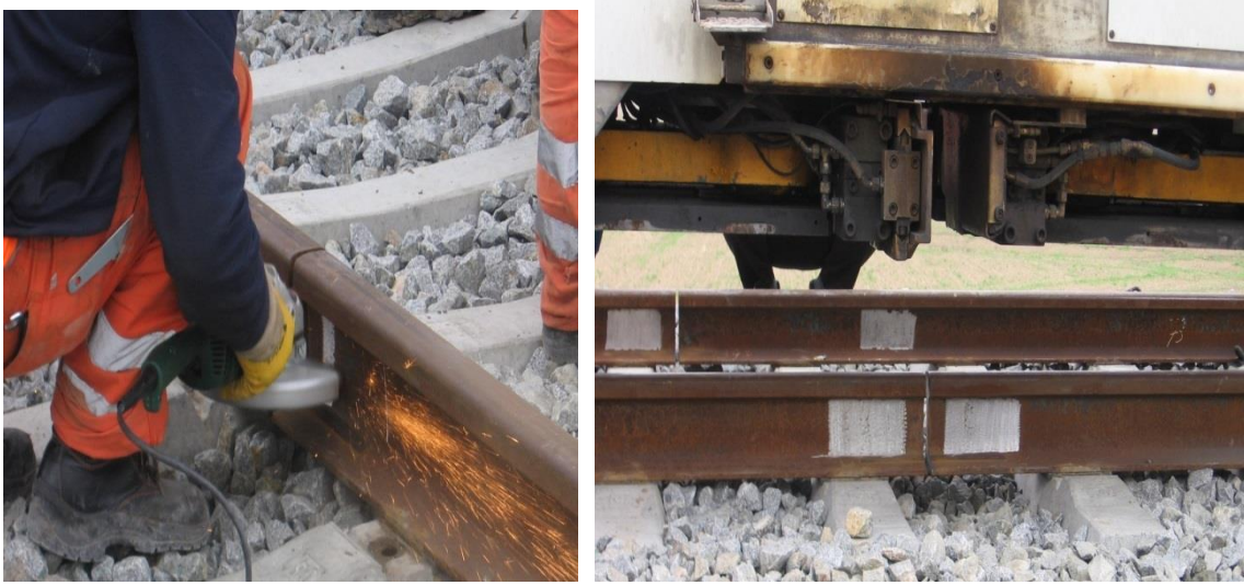
Şekil 4.9: Ray başlarının taşlanması
