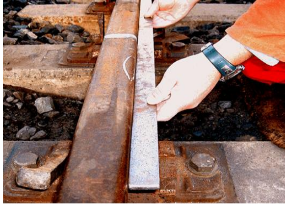
Şekil 4.15: Rayın kaynak öncesi masterlanması
