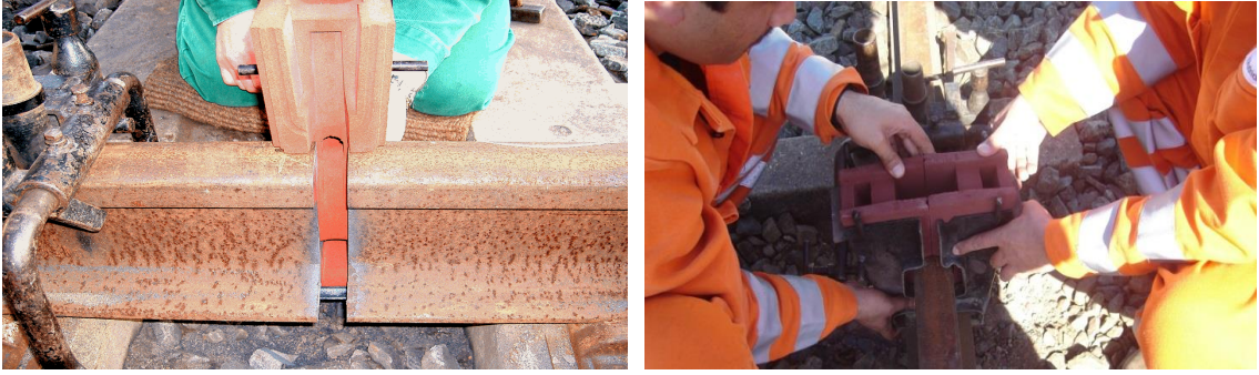
Şekil 4.16: Kalıpların bağlanması
