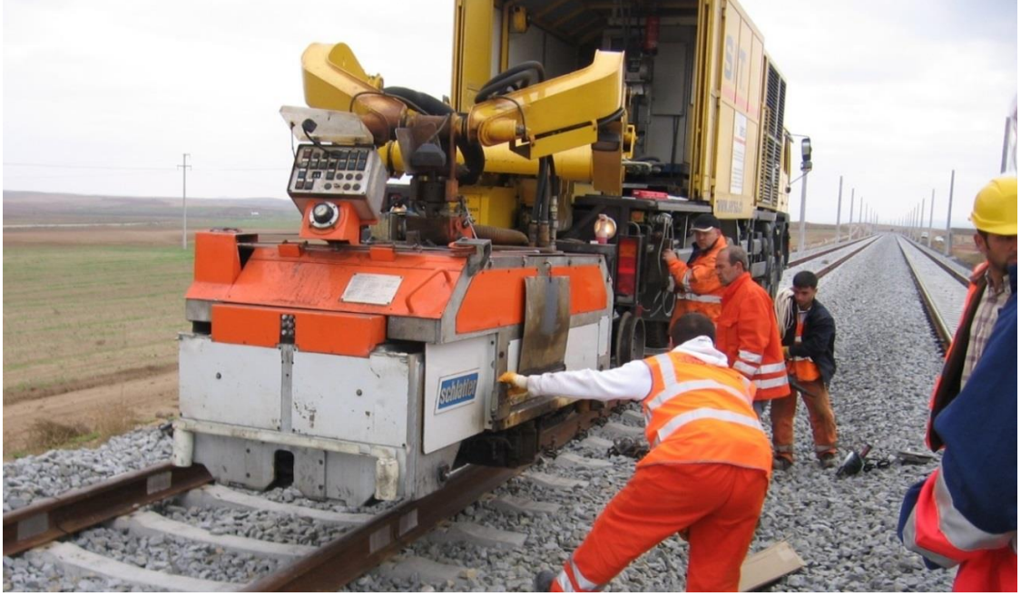
Şekil 4.8: Mobil Yakma Alın Kaynak Makinası
