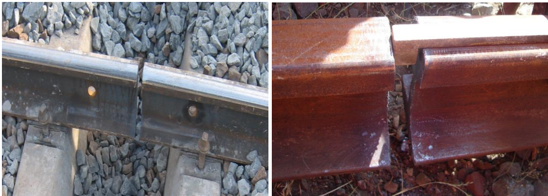
Şekil 4.14-a: Contanın kalıp bağlanmaya uygun hale getirilmesi, b: Kaynak aralığının ayarlanması
