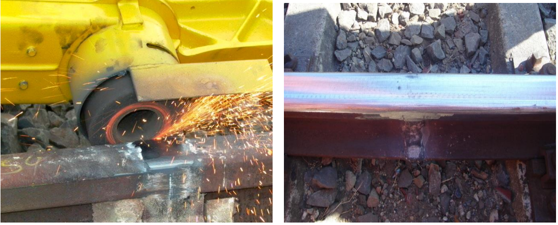
Şekil 4.26-a) Ön Taşlama işleminin yapılması, b) İnce Taşlama Sonrasında Kaynaklı Rayın Görünümü
