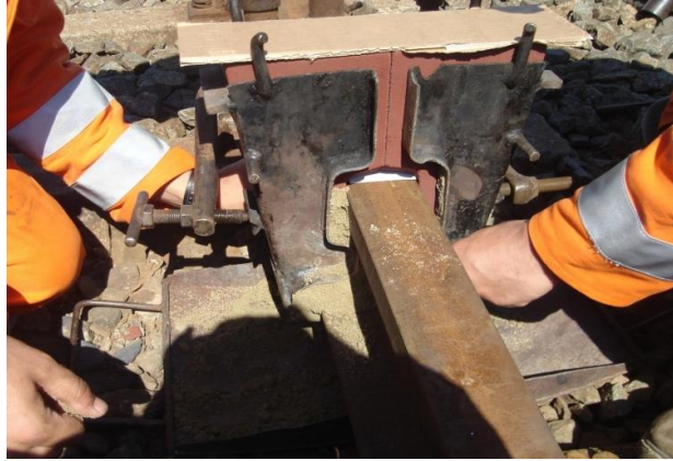
Şekil 4.17: Kalıpların macunlanması
