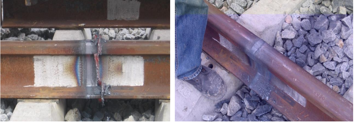
Şekil 4.11: Kaynak bölgesinin sıyırma sonrası görünümü
