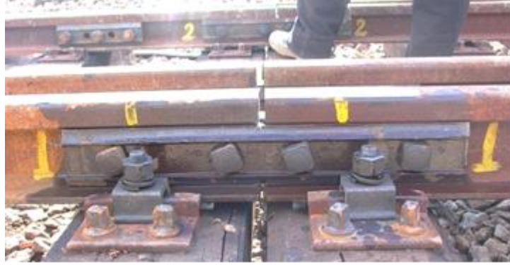
Şekil 4.1: Cebireli Ray Bağlantısına Bir Örnek (Kaçer, 2008 a)
