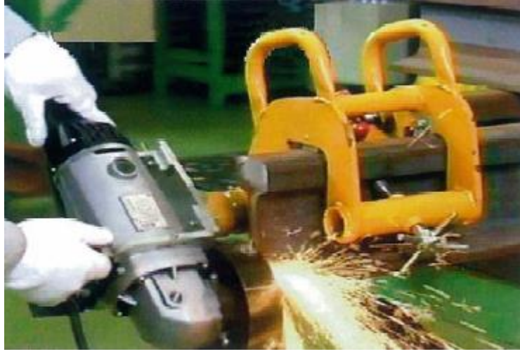
Şekil 4.27: Ray başları yüzeylerinin taşlanması
