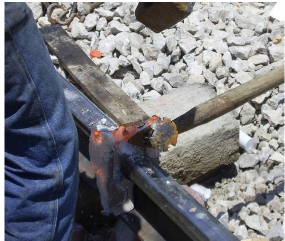
Şekil 4.25-a) Kaynak bölgesinin sıyrılması, b) Kaynak bölgesinin sıyrılması
