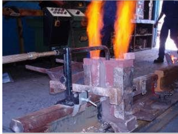
Şekil 4.21: Ray uçlarının ön ısıtma işlemi
