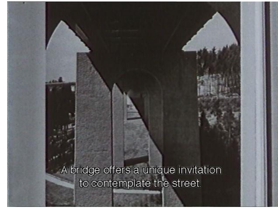
Şekil 61: 234. Aralık, Köprü Ayakları.
