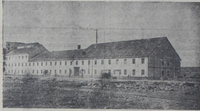
Eskişehir şeker fabrikası
