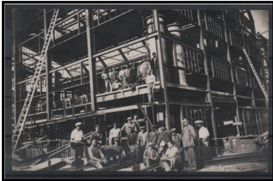
Fotoğraf 2: Eskişehir Şeker Fabrikasının Kazan Dairesi Montajı 1933
