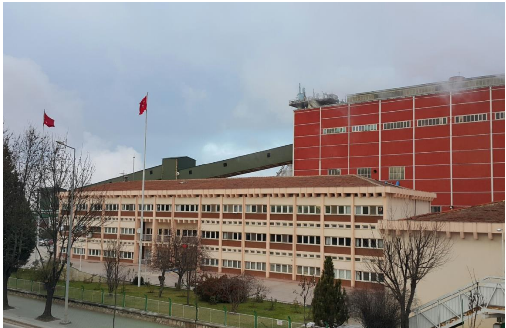
Fotoğraf 4: Eskişehir Şeker Fabrikası Genel Görünüm Aralık 2014
