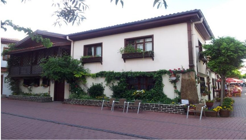
Resim 4.8. Yeni Hamamönü (Kişisel çekim)-1
