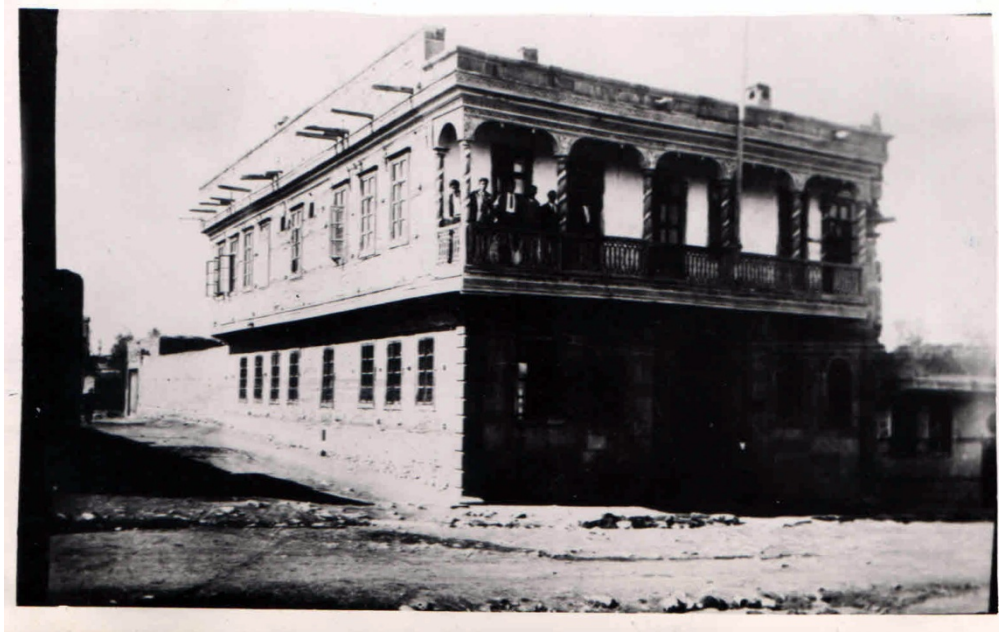
Resim 3. Dispanser Binası ve Tatbikat Okulu
