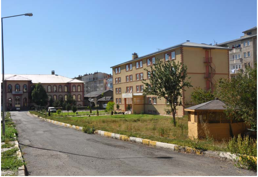
EK 10. Nenehatun Anadolu Lisesi ve Yurt Binası
