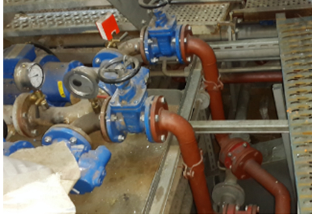
Şekil 4.17 Boru devre finalleme işleri
