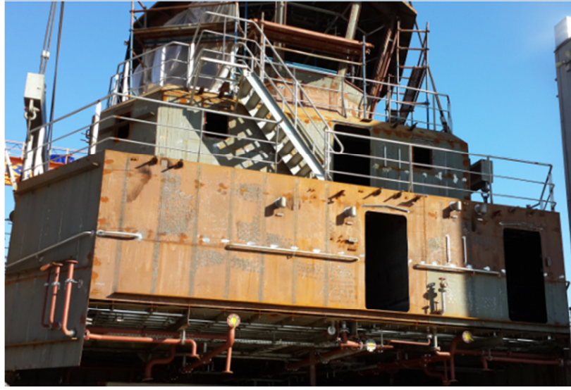
Şekil 4.12: Donatımı tamamlanmış örnek bir blok
