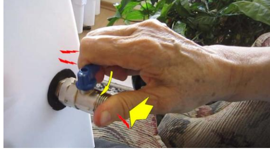
Şekil 5.39: Su açma kapama vanası (bkz. Çizelge 5.7.4E).
