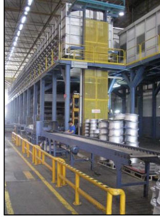
Şekil 1.32 : Isıl işlem tesisi.
