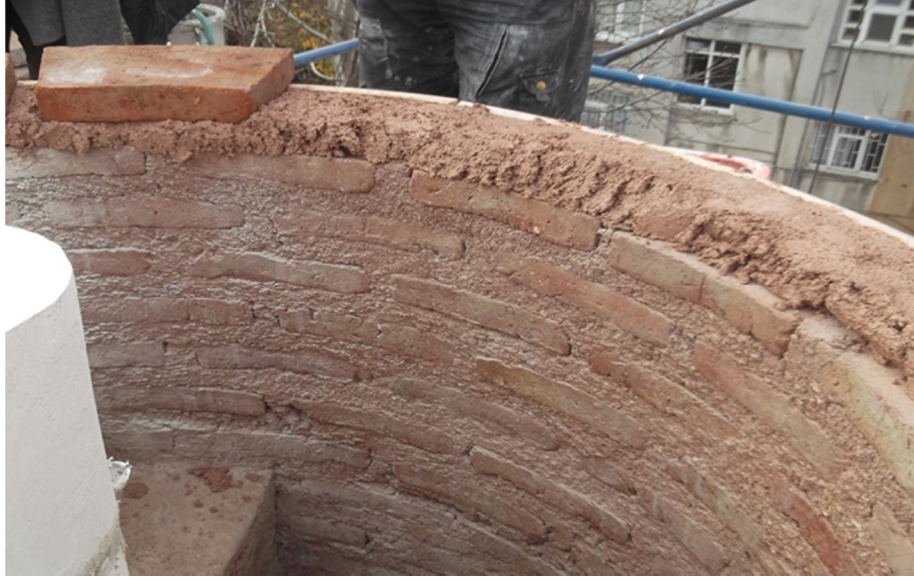
Şekil 2. 5 : Derz kalınlığına örnek.
