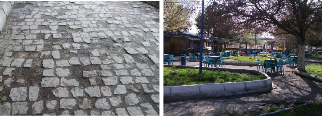
Şekil 4.47. Kurtuluş Parkı Yol Döşemesi
