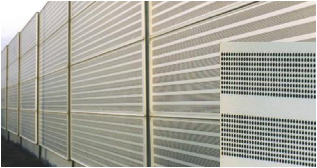
Şekil 1.16: Ön yüzü delikli metal gürültü bariyeri örneği- Danimarka (Bendtsen, 2010).
