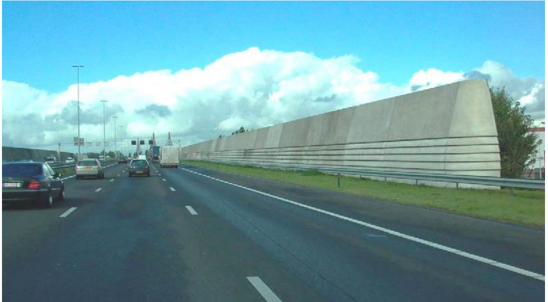
Şekil 1.13: Eğik konumlu gürültü bariyeri örneği – Danimarka (Bendtsen, 2010).
