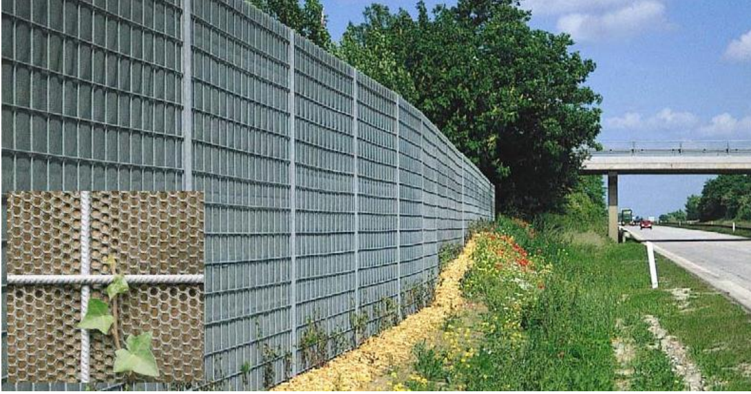
Şekil 1.17: Çelik çerçeve içine taş yünü ve ön yüzü hasır donatı kaplı gürültü bariyer örneği – Danimarka (Bendtsen, 2010).
