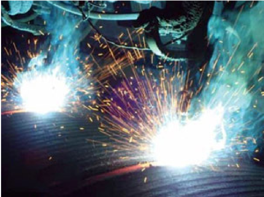
Şekil 2.2 : Tambur üzerinde gerçekleştirilen kaynak uygulaması
