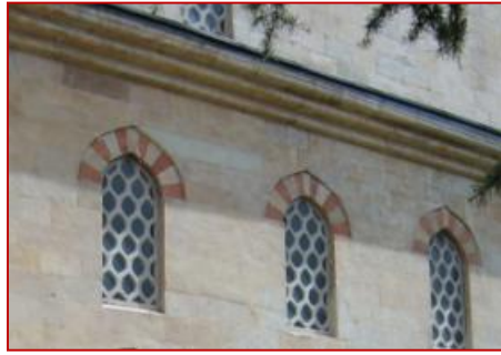
Şekil 49: Sivri kemerli alçı şebekeli pencereler. (2014)
