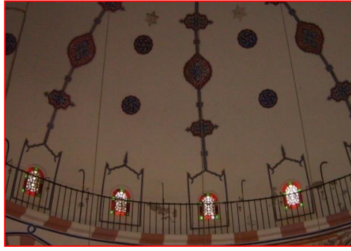
Şekil 106-107: 2010 onarımında orta ve üst kasnak pencereler ile fil gözü penceresinin etrafındaki kalemişleri kapatılmıştır. (2014).
