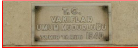
Şekil 17: Sağdaki pencere alınlığında dikdörtgen panoda yer alan onarım levhası. (2014).
