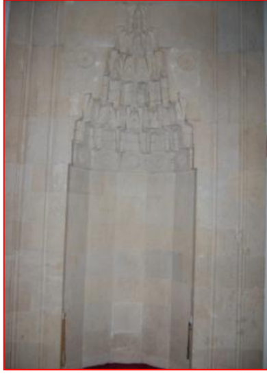
Şekil 26: Beş kenarlı mihrap. (2014).
