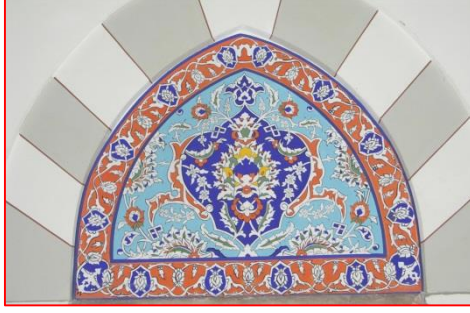
Şekil 99: 2007 onarımı (VGM Arşivi)
