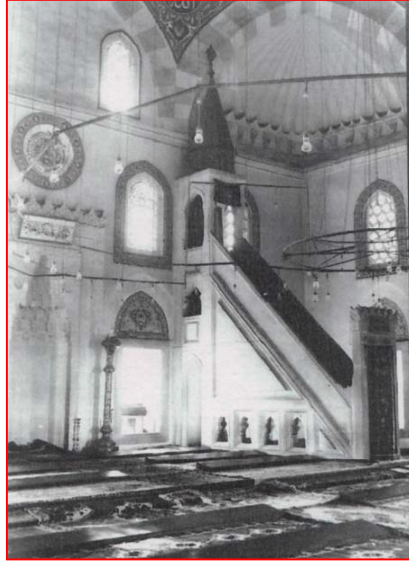
Şekil 69: Camide zemin şap yapılmadan önce bulunan ahşap secdelikler (VGM Arşivi).
