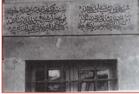
Şekil 67: 1969’da değiştirilmiş olan ahşap pencere doğramaları (VGM Arşivi).
