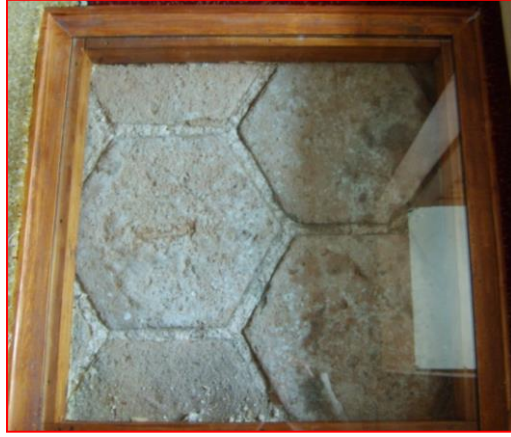
Şekil 98: Yapının korunan ilk dönem tuğla döşemesi. (2014).
