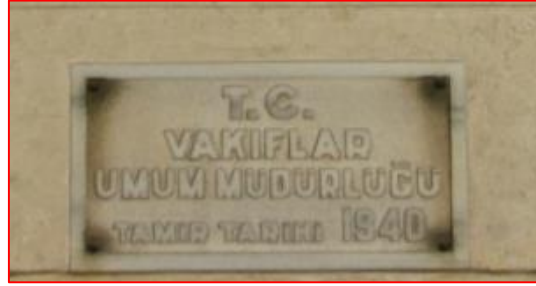
Şekil 64: Taç kapının sağında yer alan onarım levhası (2014).
