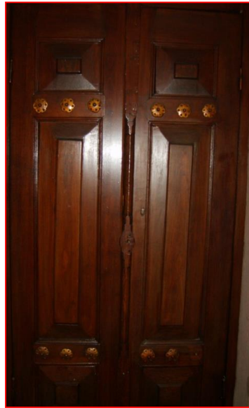
Şekil 116: Ahşap pencere kepenklerinin son hali. (2014).
