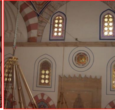
Şekil 106-107: 2010 onarımında orta ve üst kasnak pencereler ile fil gözü penceresinin etrafındaki kalemişleri kapatılmıştır. (2014).
