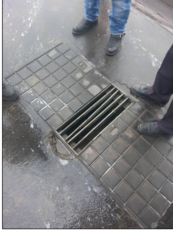
Şekil 6.6 : Araç yıkamanın bitimindeki çöktürme havuzu.
