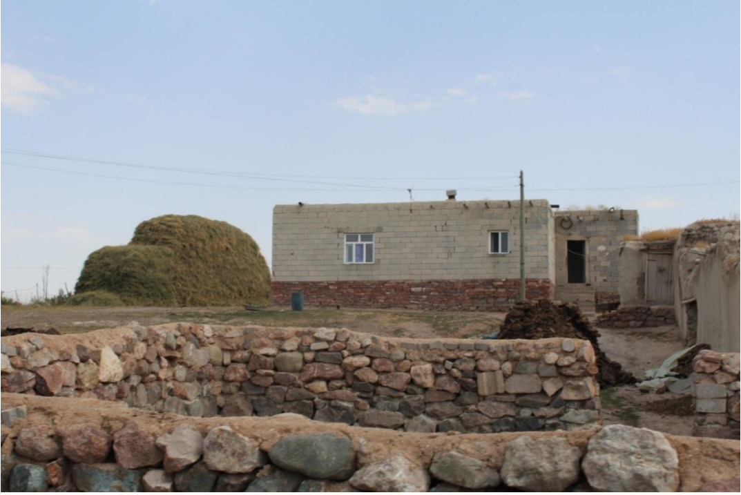
Resim 12: Aşağı Dönerdere’de tabanı taştan üst kısmı kerpiçten yapılmış, sıvasız yeni bir ev.
