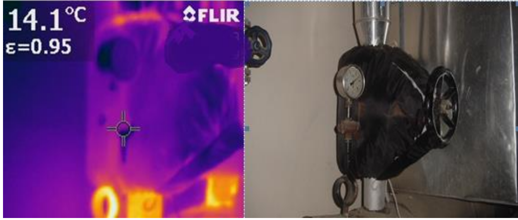
Şekil 2.45 Vana çeketi ile izolasyon örnekleri
