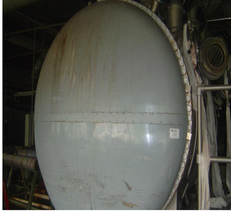
Şekil 1.6 Ana tank üzerindeki yan bombe izolasyonu uygulaması-foam köpük izolasyon uygulaması
