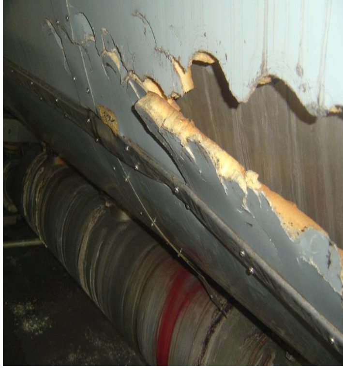
Şekil 1.7 Ana tank üzerine yapılmış yüzey izolasyonu-sarı foam köpük ile kaplama
