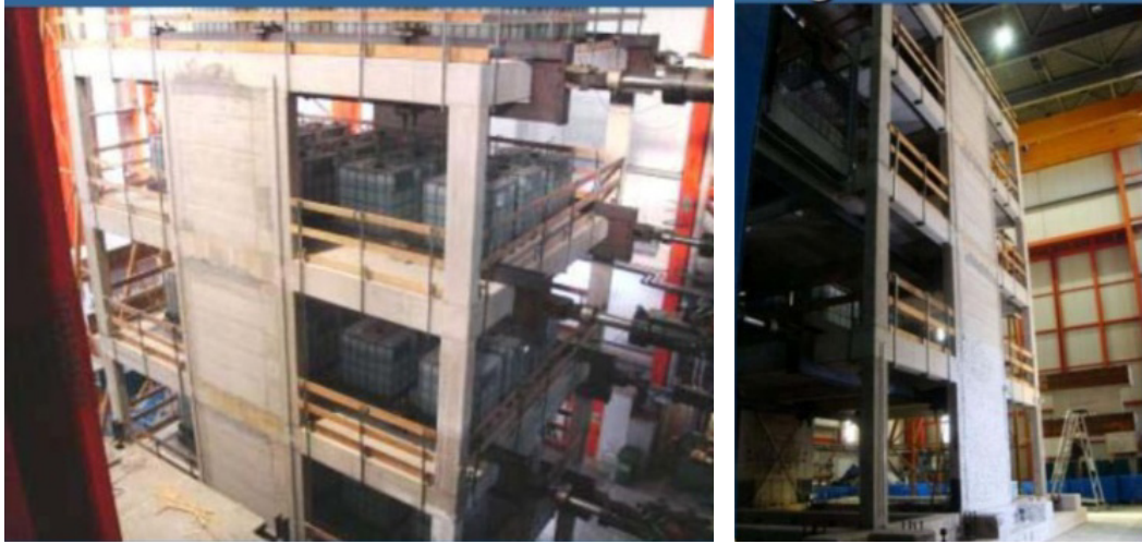
Şekil 1.16 : Güçlendirilmiş betonarme perdelerden oluşan tam ölçek 3 katlı betonarme sistem (Chrysostomou ve diğ, 2012).
