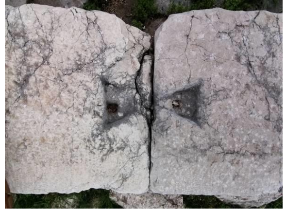
c Kat. 32 Kırılmaç Kuyruğu Formlu Bir Kenet İçin Yuva
