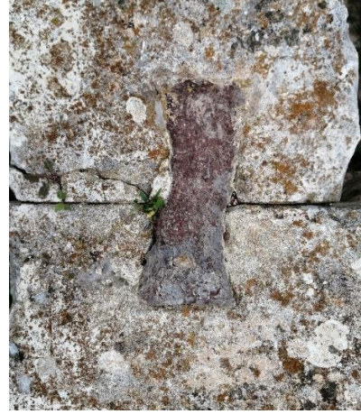
c Kat. 21 Kırılmaç Kuyruğu Formlu in situ Kenet
