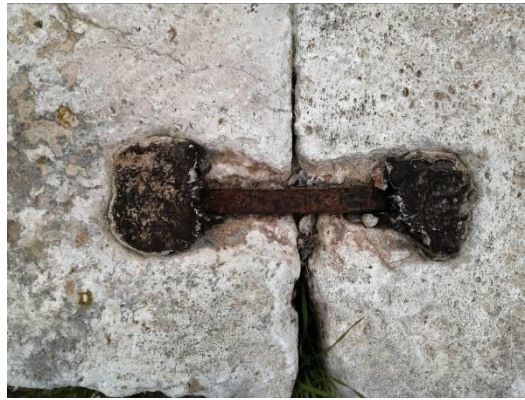
d Kat. 11 II (pi) Formlu in situ Kenet Kalıntısı
