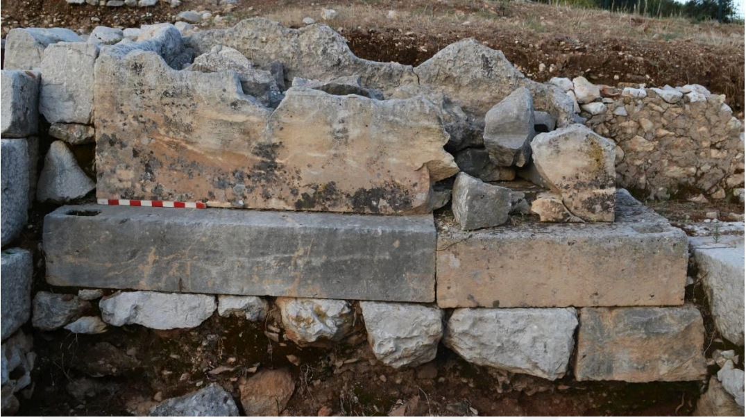
a Kat. 31 Cephe
