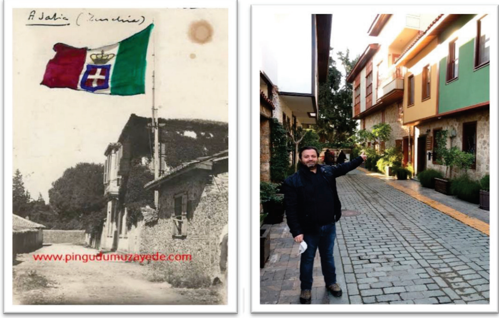
Görsel 19: İtalyanların 1913’de Açtıkları İlk Konsolosluk Binası ve Bugünkü Görünüşü (sağda), (www.pingudumuzayede.com, Kaynak Hüseyin Kanber).
