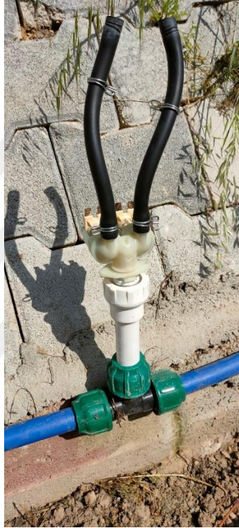
Şekil 3.8. Selenoid valfin damla sulama sistemine montajı
