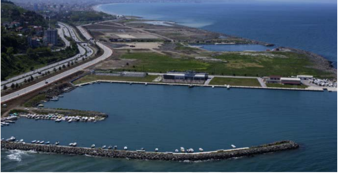
Şekil 6. Batı Park dolgu yapım süreci
