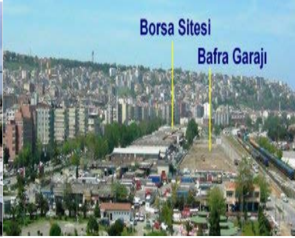
Şekil 48. Yıkılan Borsa Sitesi ve Bafra garajı
