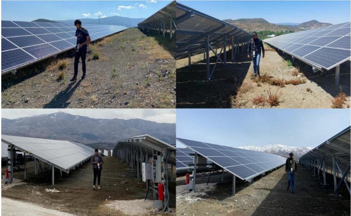
Şekil 3.15. Santral sahasında çeşitli tarihlerde gerçekleştirilmiş karkas tarama çalışmaları
