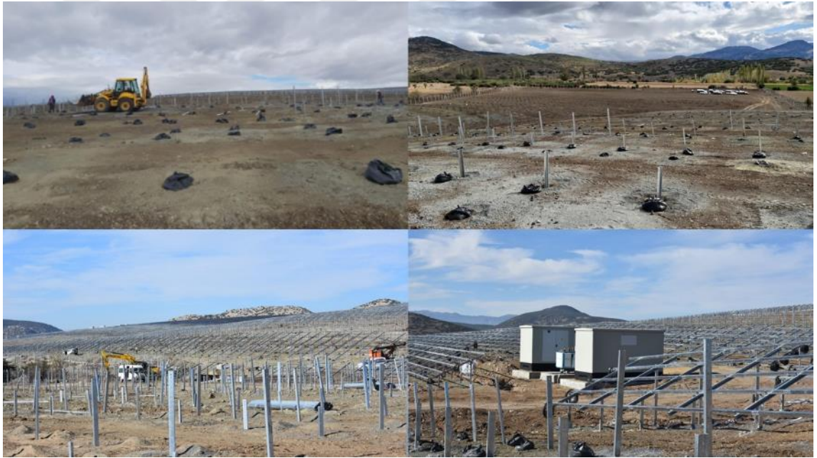
Şekil 4.3. Alüminyum taşıyıcıların kurulması
