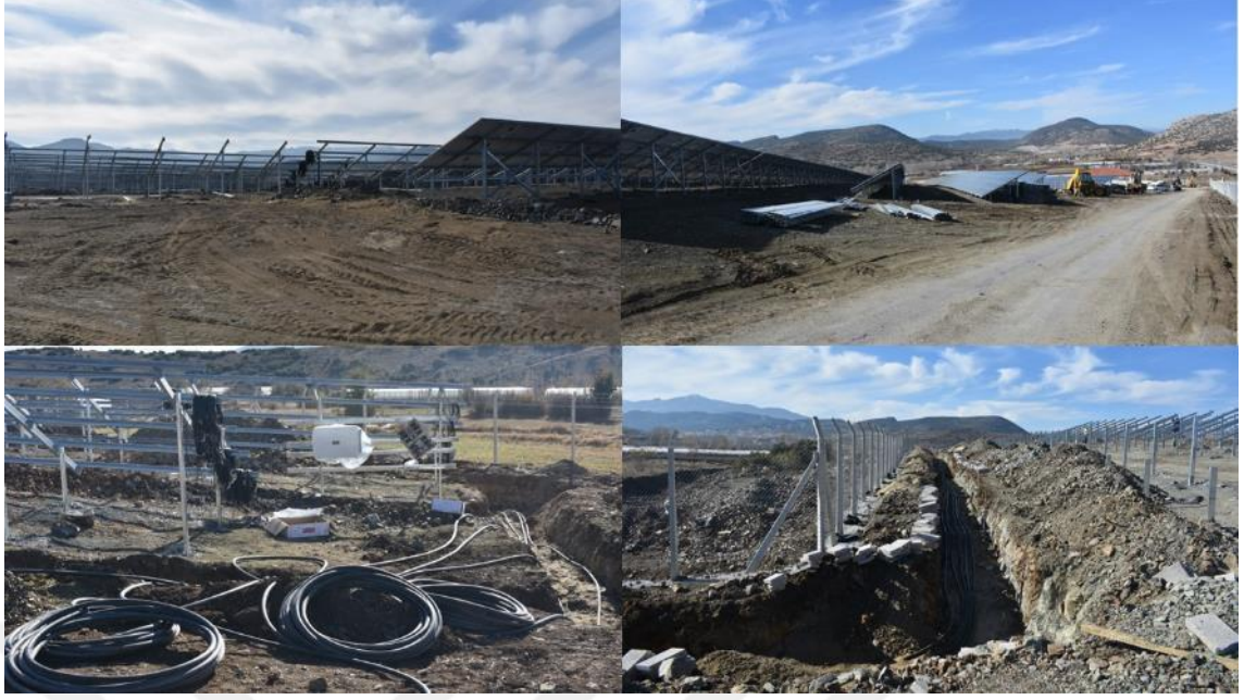
Şekil 4.4. Panellerin, elektrik iletim hatlarının ve tel örgülerin kurulması
