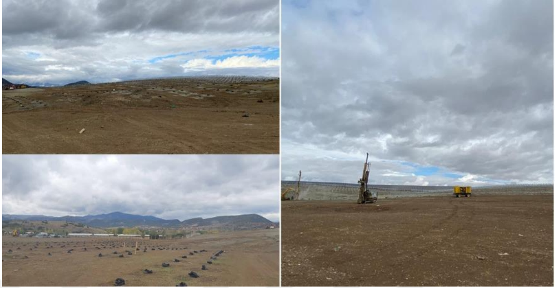
Şekil 4.2. Bitki örtüsünün sökülmesi ve sahanın düzlenmesi
