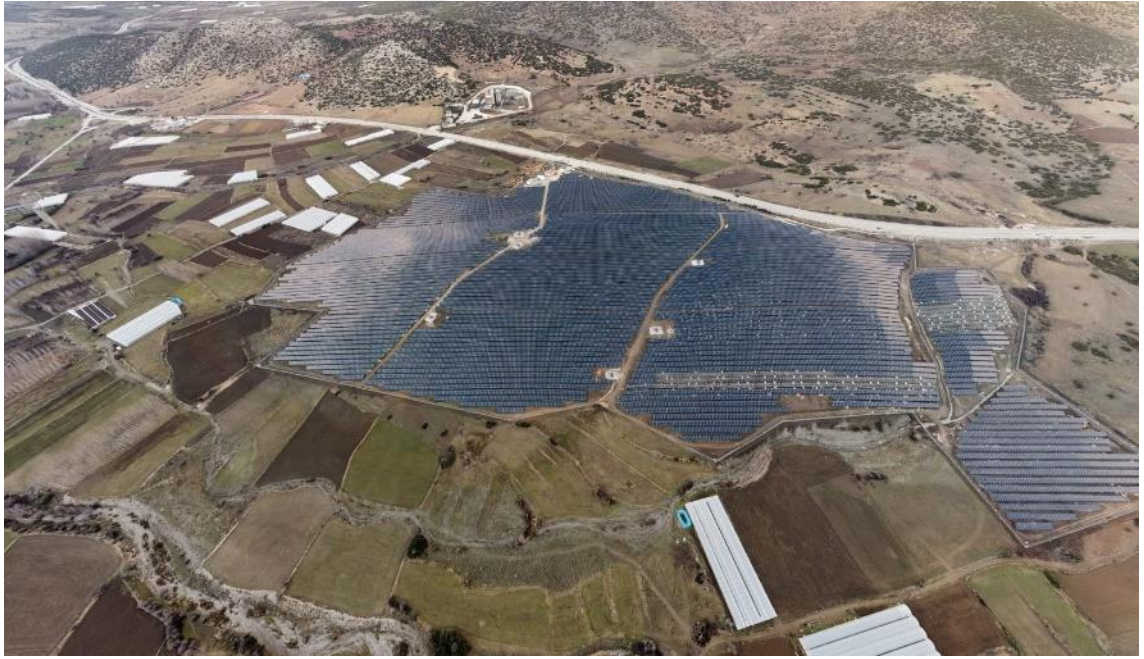
Şekil 4.5. İnşaat çalışmalarının tamamlanmasının ardından sahanın drone ile çekilmiş görüntüsü
