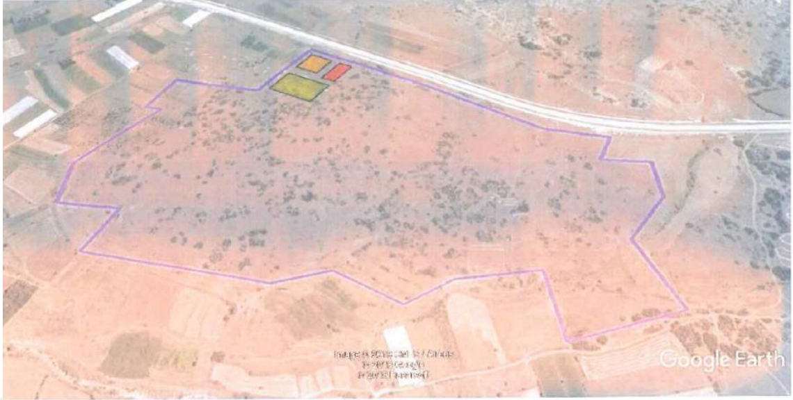
Şekil 3.6. Proje sahasının inşaat çalışmaları başlamadan önceki uydu görüntüsü
