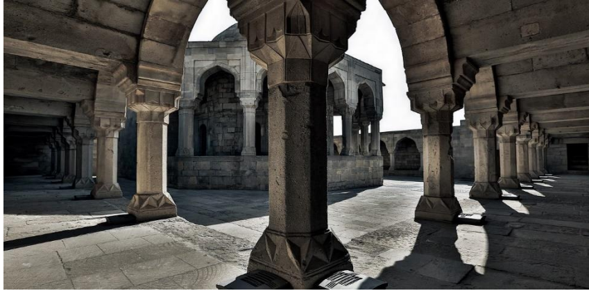
Şekil 9: Şirvanşahlar Sarayı Kompleksi, Divan Yolu
