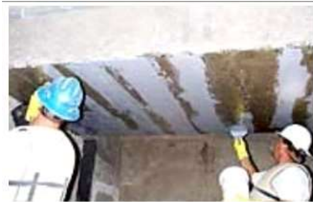
Şekil 4.10. Yüzeye astar uygulaması
