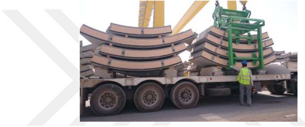
Şekil 5.1. Taşıyıcıya betonarme prekast segmentlerin yüklenmesi
