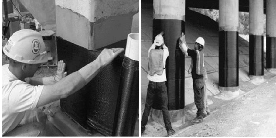
Şekil 3. 3 Kolonlarda FRP sargı uygulaması [24]
